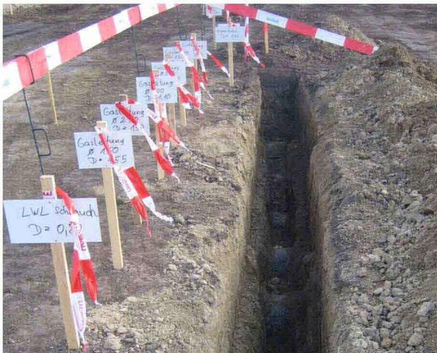
Abb. 5.1: Kennzeichnung von Fremdleitungen<sup>70</sup>
