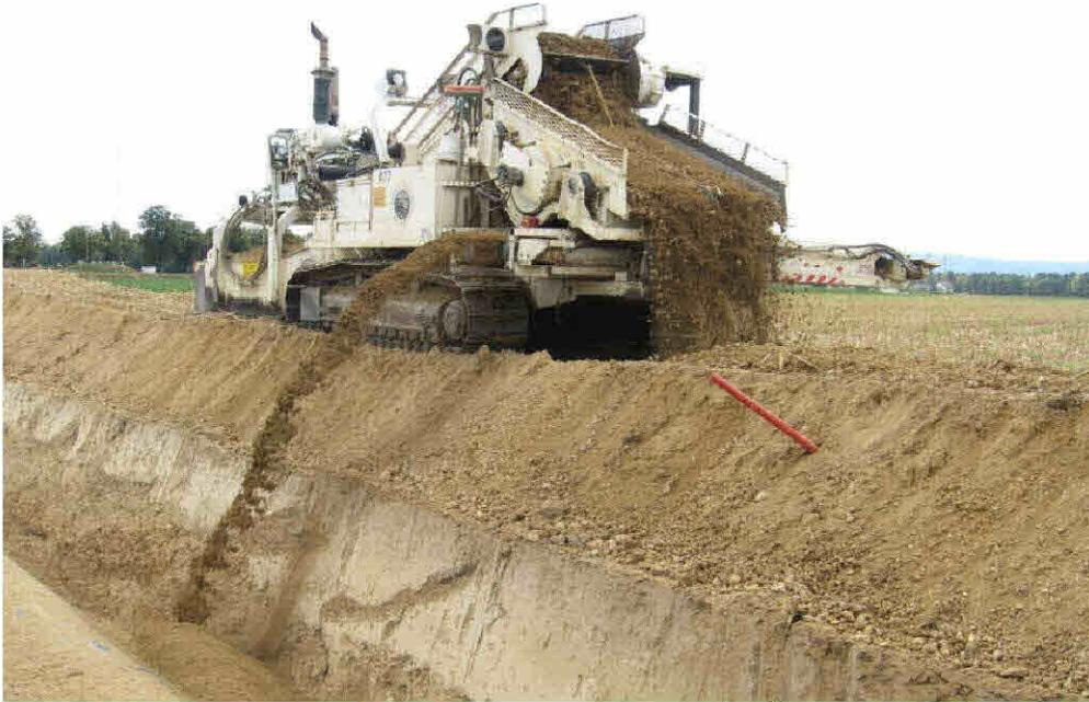
Abb. 5.15: Verfüllen des Rohrgrabens<sup>94</sup>
