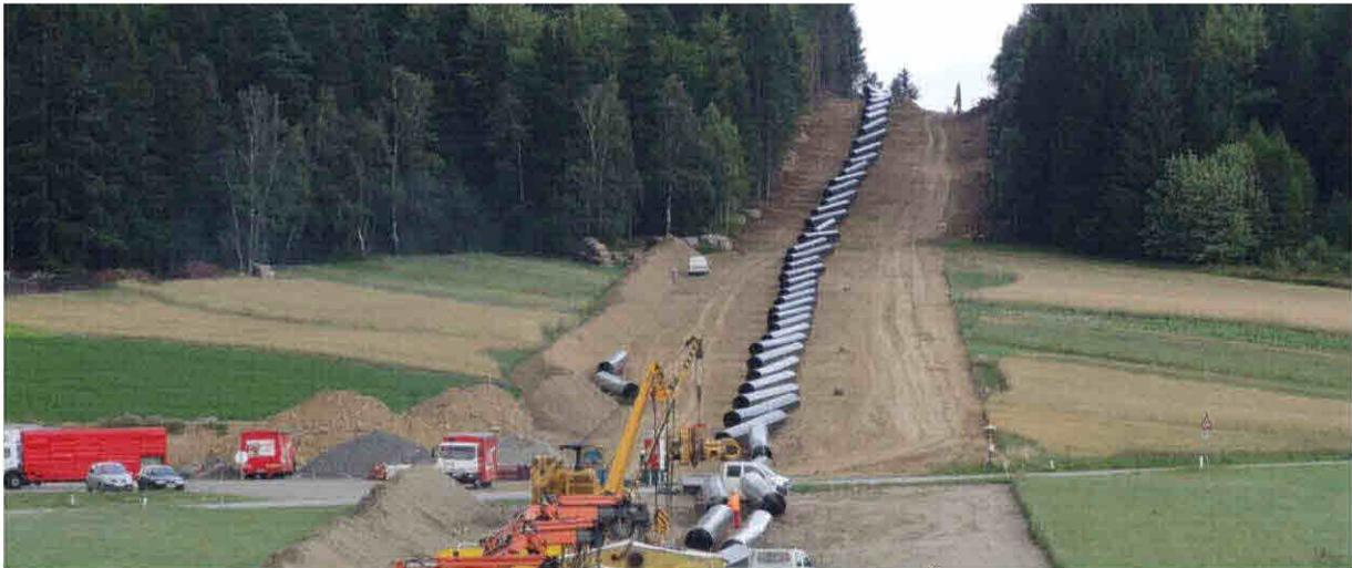
Abb. 5.3: Rohrlagerung entlang der Trasse<sup>72</sup>
