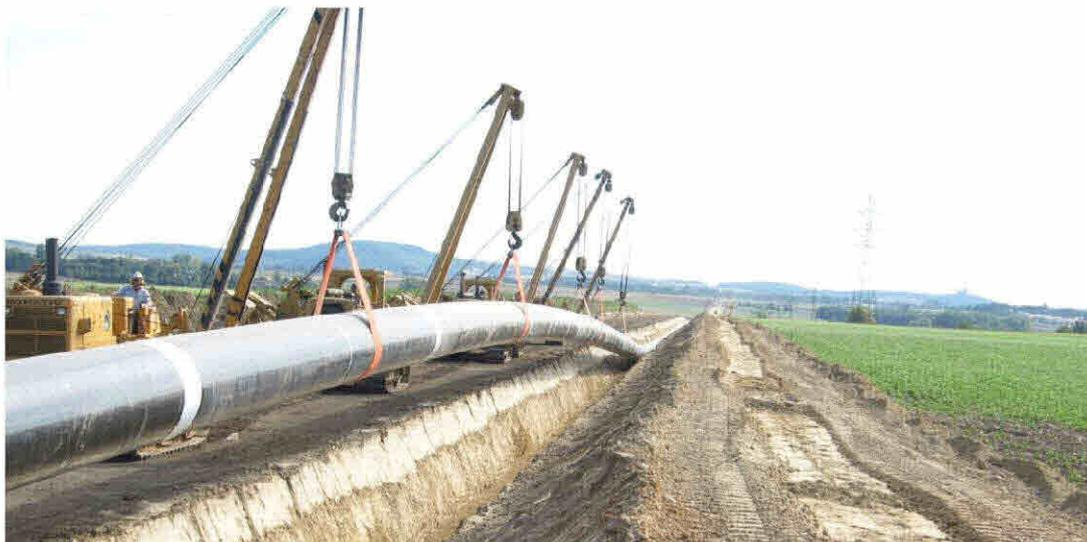
Abb. 5.12: Absenken des Rohrstranges<sup>90</sup>
