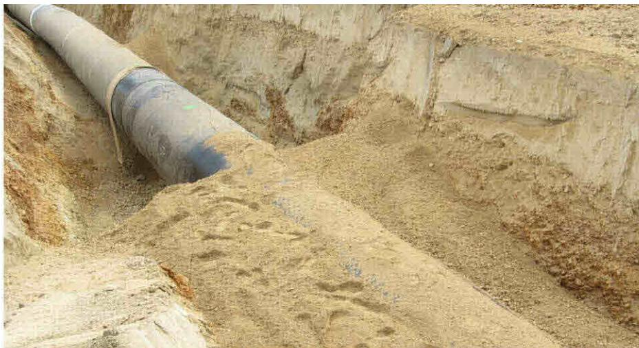
Abb.5.13: Verfüllen des Rohrgrabens<sup>92</sup>
