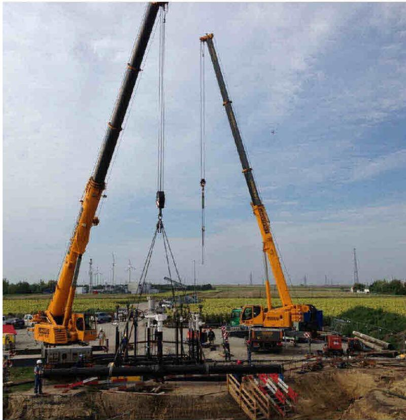
Abb. 5.22: Einheben einer Station<sup>117</sup>
