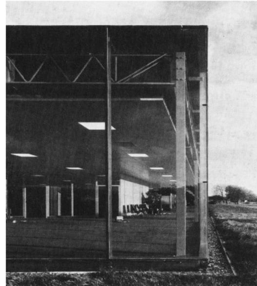
Abbildung 58 Mehrzweckgebäude der Firma IBM in Cosham von Norman Foster, 1972, leichtes Stahltragwerk aus Holzstützen und filigranen Trägern sowie ganzflächiger Glasfassade
