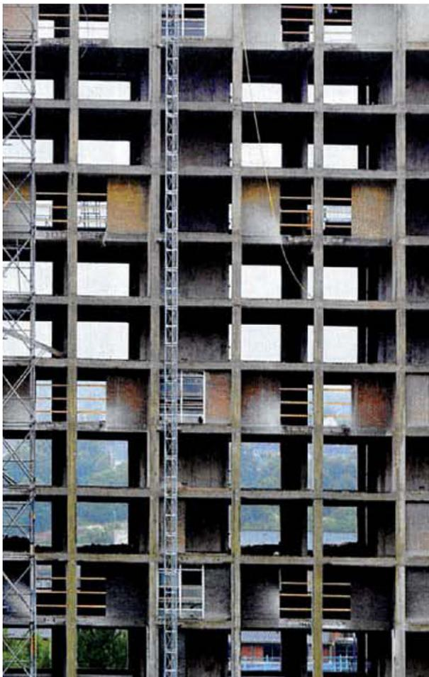
Abb. 43: Totalsanierung: nur das Tragwerk bleibt erhalten
