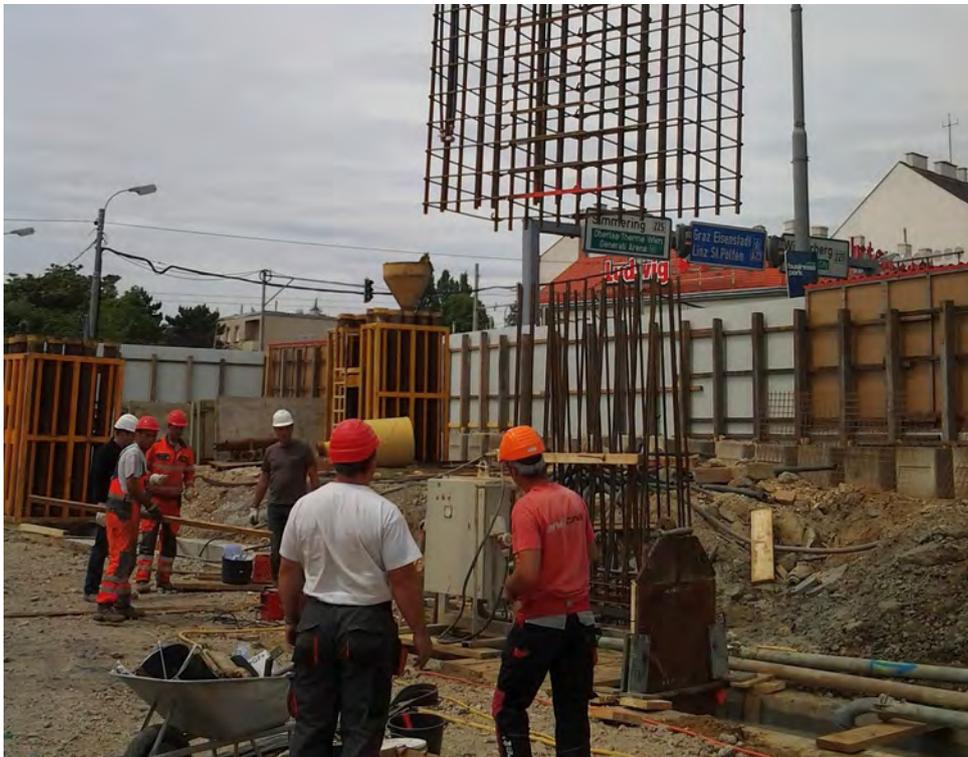
Abbildung 4.21: Zweiter Bewehrungskorb wird über den ersten gehoben<sup>147</sup>
