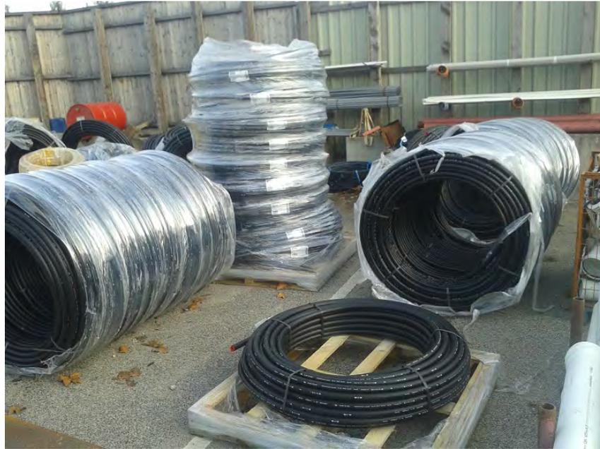
Abbildung 4.1: Lagerung der Wärmeüberträger auf der Baustelle<sup>63</sup>
