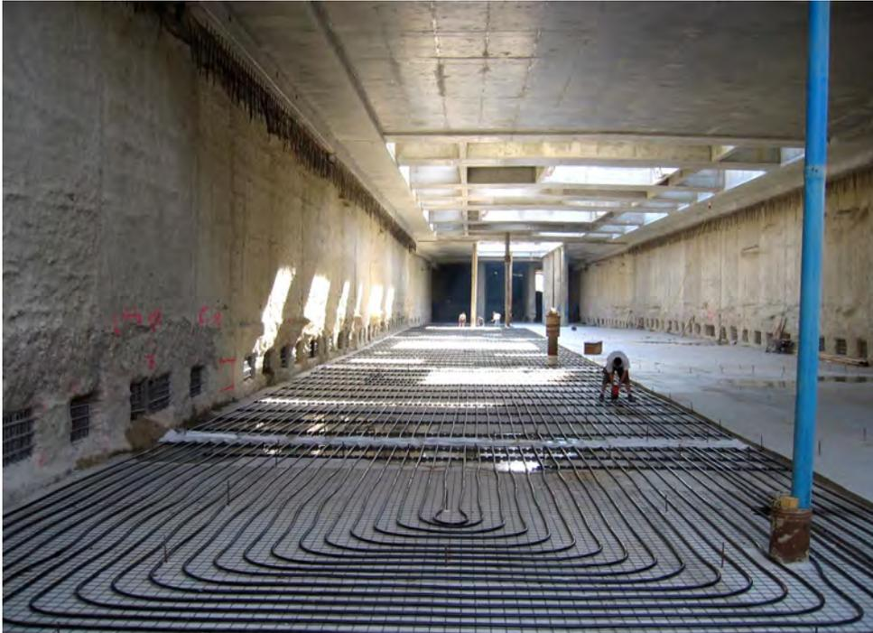
Abbildung 4.11: Aktivierung unter der Bodenplatte bei U2 Station Messe<sup>106</sup>
