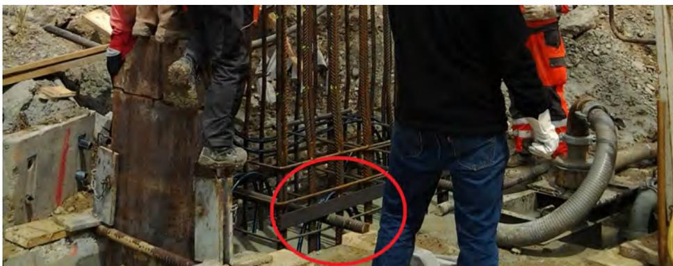
Abbildung 4.20: Befestigung des Bewehrungskorbes an der Leitwand<sup>144</sup>
