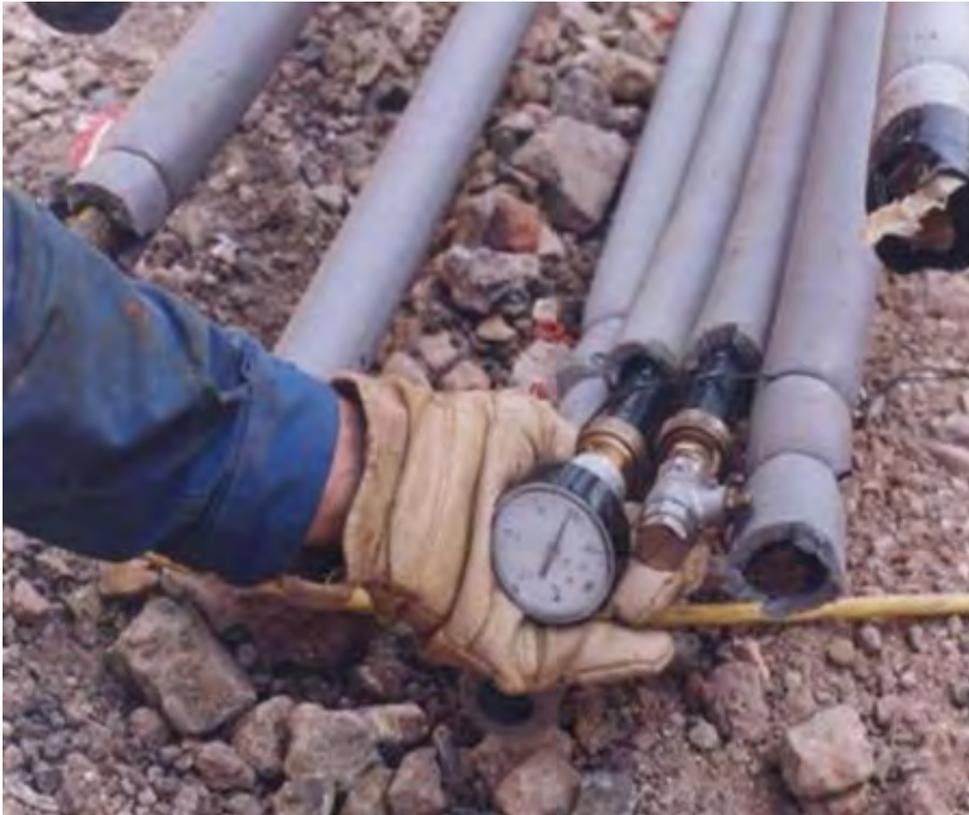
Abbildung 5.1: Qualitätskontrolle mittels Manometer<sup>197</sup>
