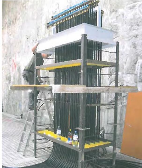
Abbildung 4.33: Druckwasserdichte Durchführung durch 2 m dicke Bodenplatte<sup>185</sup>
