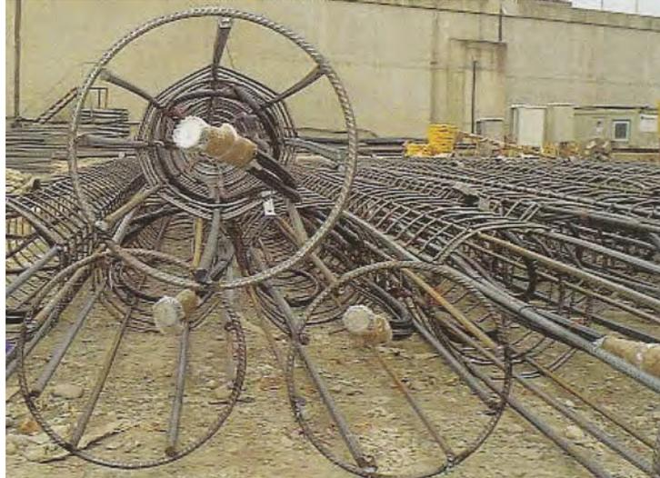
Abbildung 4.16: Belegte Pfahlbewehrungskörbe<sup>125</sup>
