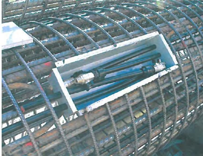
Abbildung 4.15: Anschlusskasten<sup>120</sup>
