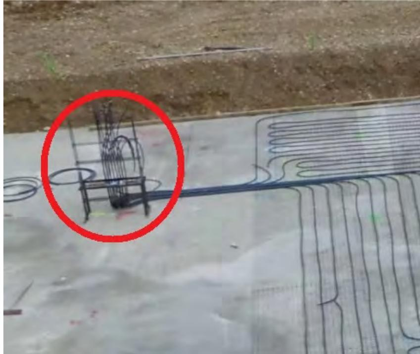
Abbildung 4.12: Verteiler und Bodenplattendurchlass<sup>108</sup>
