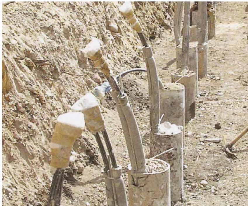
Abbildung 4.19: Hohlpfähle aus Stahl<sup>137</sup>
