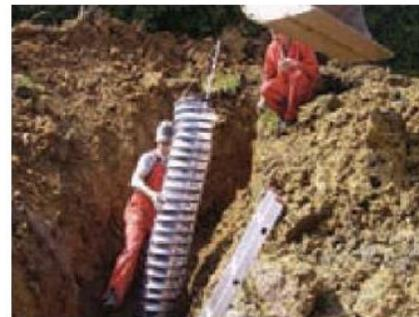
Abb. 3. 6: Schema eines Svec-Kollektors (links) [30] und Einbau eines Svec-Kollektors (rechts) [28]
