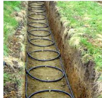
Abb. 3. 5: Schema eines Slinky-Kollektors (links) [30] und Einbau eines Slinky-Kollektors (rechts) [28]
