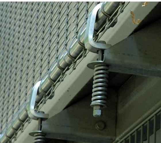
Anstelle der Verankerung im Boden können auch Haken verwendet werden, die an der Fassade befestigt sind.
