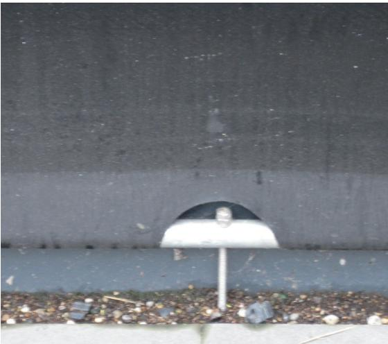
In diesem Beispiel wird die Membran mit Hilfe eines Rohres nach unten gespannt und im Boden verankert.
