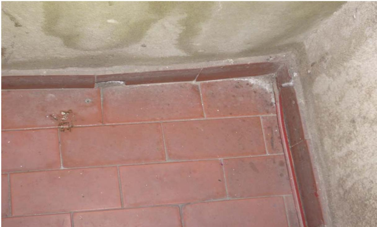
Abb. 32: Feuchteschäden an der Brüstungsplatte (Eigene Abbildung)
