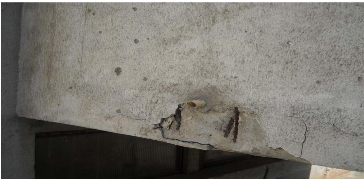
Abb. 29: Schäden an der Brüstung zufolge ungeeigneter Entwässerung
