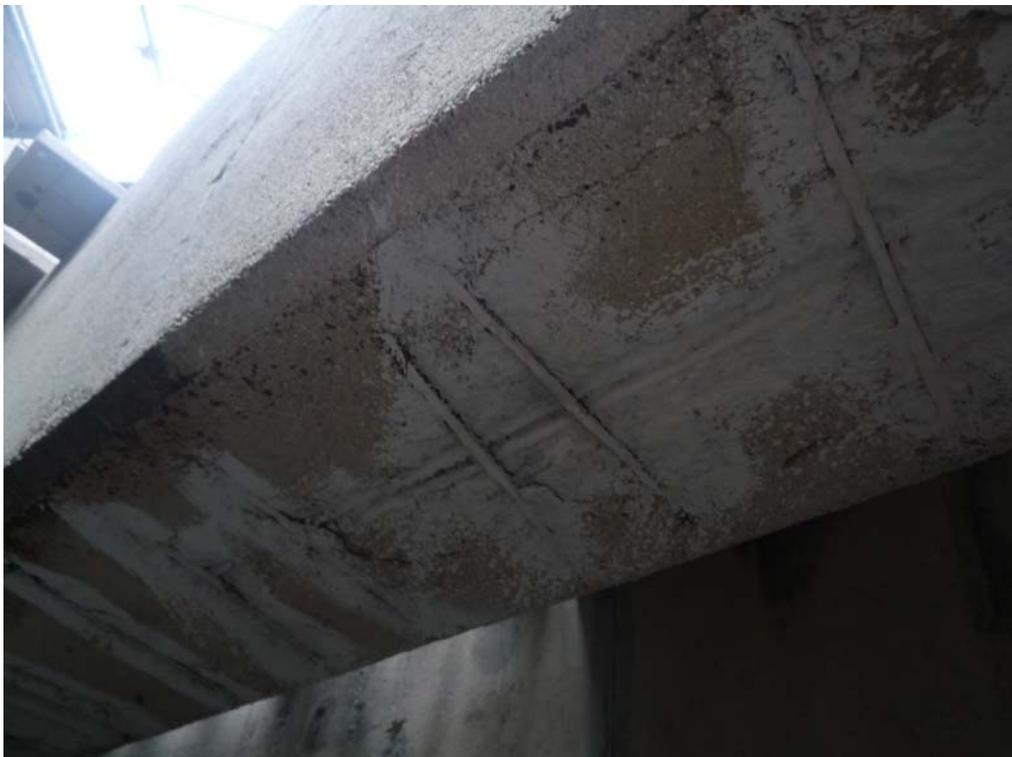
Abb. 56: Geschädigter Stahlbetonbauteil nach der Instandsetzung vor der Anbringung des Oberflächenschutzes und der Endbeschichtung<sup>50</sup>
