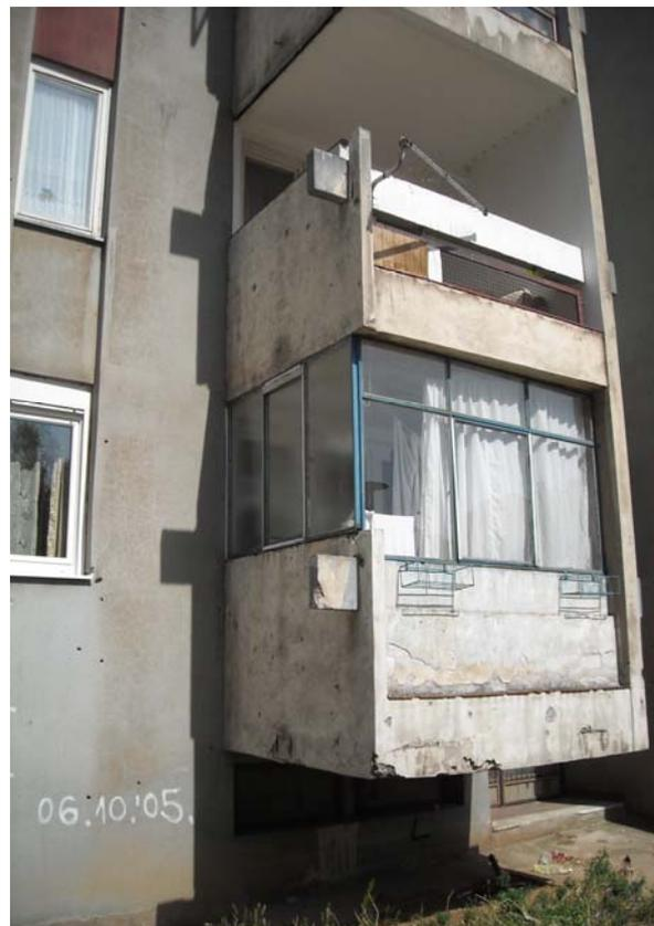
Abb. 31: Schäden zufolge fehlender Blechabdeckungen und ungeeigneter Entwässerung (Eigene Abbildung)
