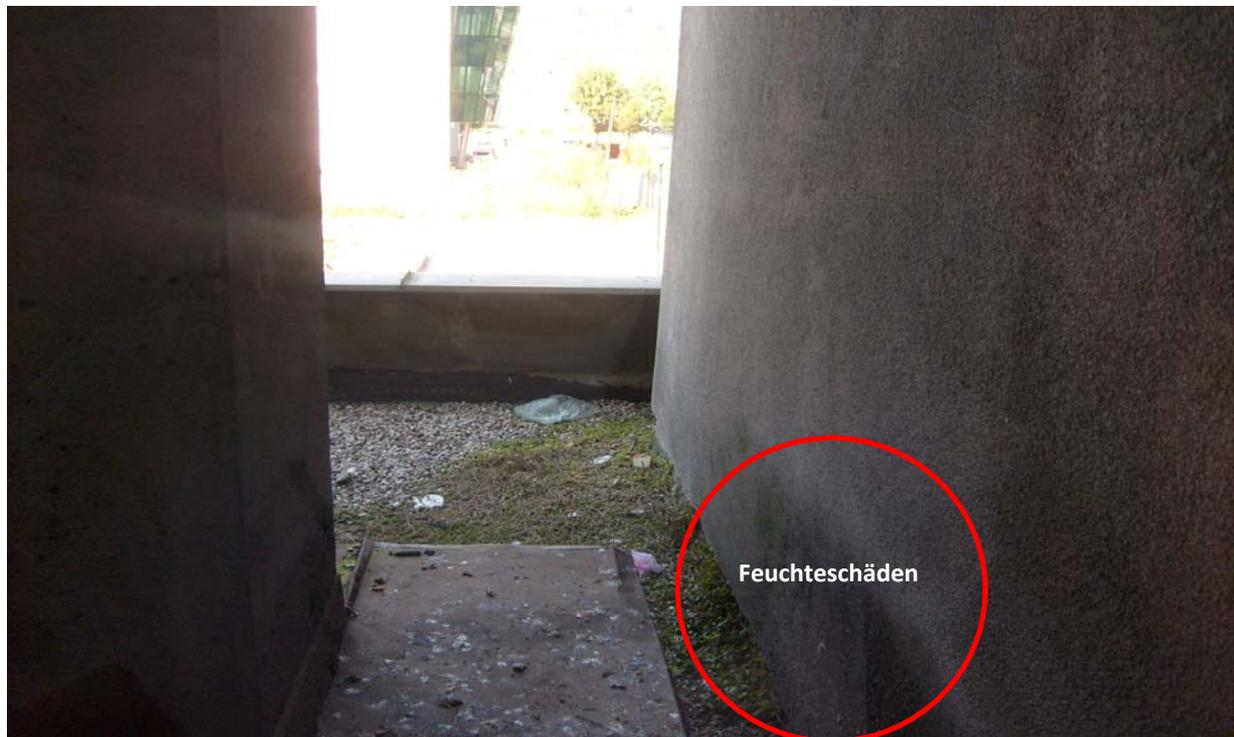
Abb. 20: Schäden an aufgehenden Bauteilen zufolge ungenügender Dachabdichtung (Eigene Abbildung)
