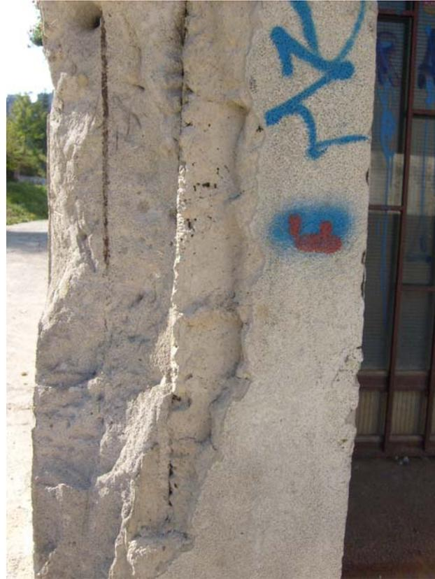
Abb. 19: Schäden an der Fassade (Stahlbeton/Siporex)
