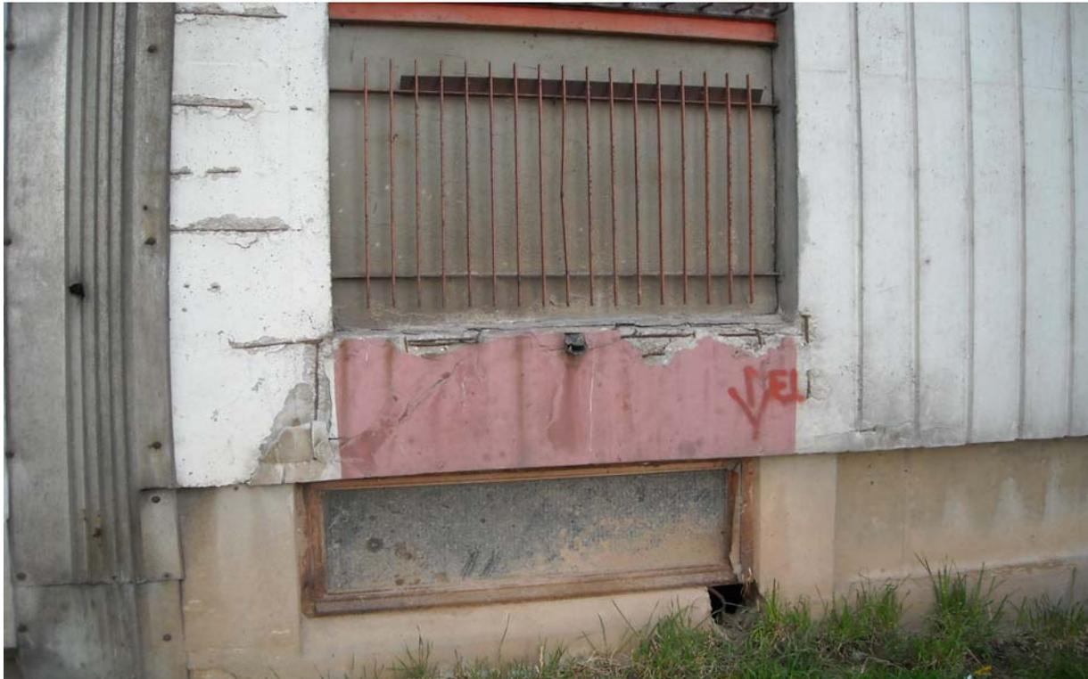
Abb. 16: Betonabplatzungen an der Fassade (Eigene Abbildung)
