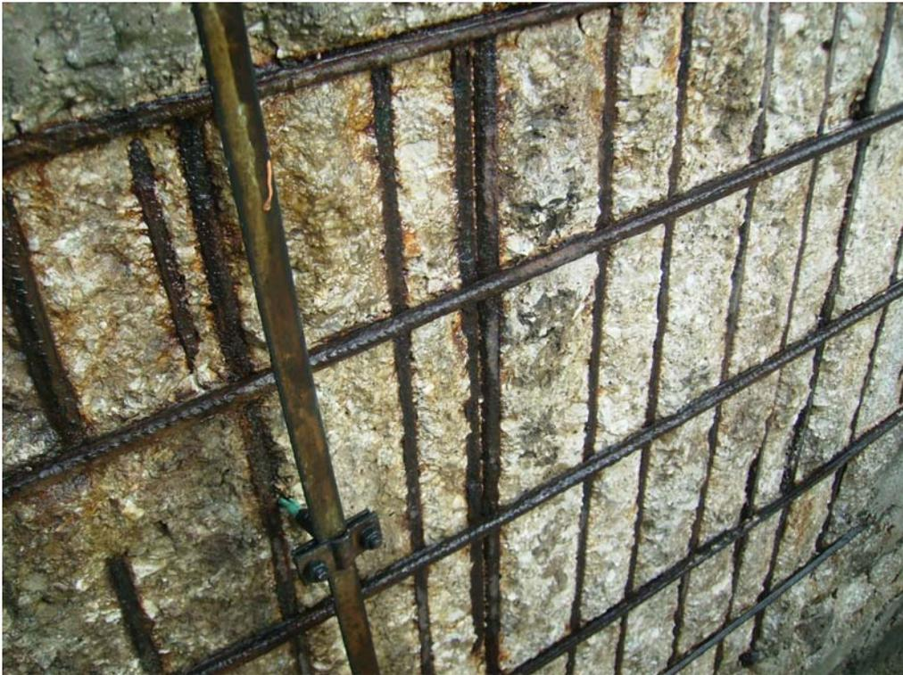
Abb. 55: Geschädigter Stahlbetonbauteil vor der Instandsetzung<sup>49</sup>
