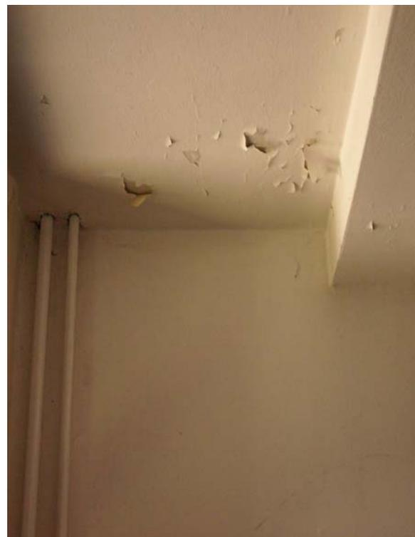
Abb. 44: Ungedämmte Steigleitungen (Eigene Abbildung)
