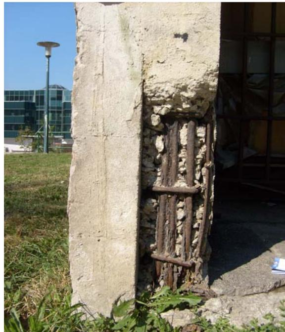
Abb. 53: Schadhafte Stahlbetonausführungen – Alipašino Polje, Sarajewo (Eigene Abbildung)
