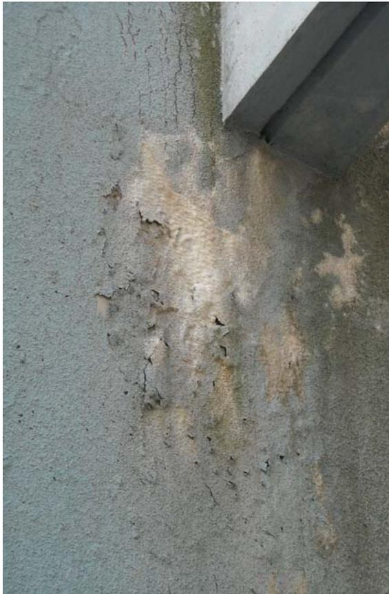
Abb. 14: Feuchteschäden an der Fassade
