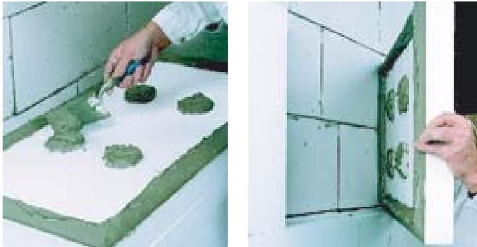
Abb. 49: Verklebung der Dämmplatten nach der Randwulst-Punkt-Methode<sup>37</sup>
