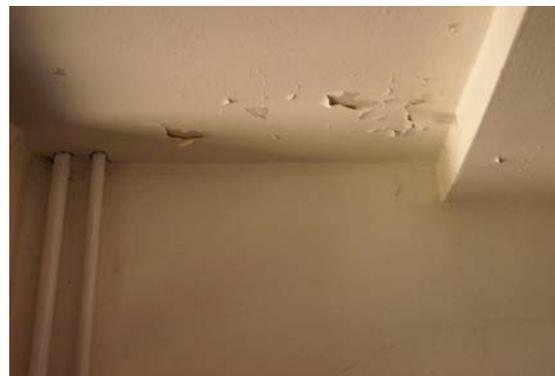
Abb. 42: Schadhafter Putz im Stiegenhaus (Eigene Abbildung)
