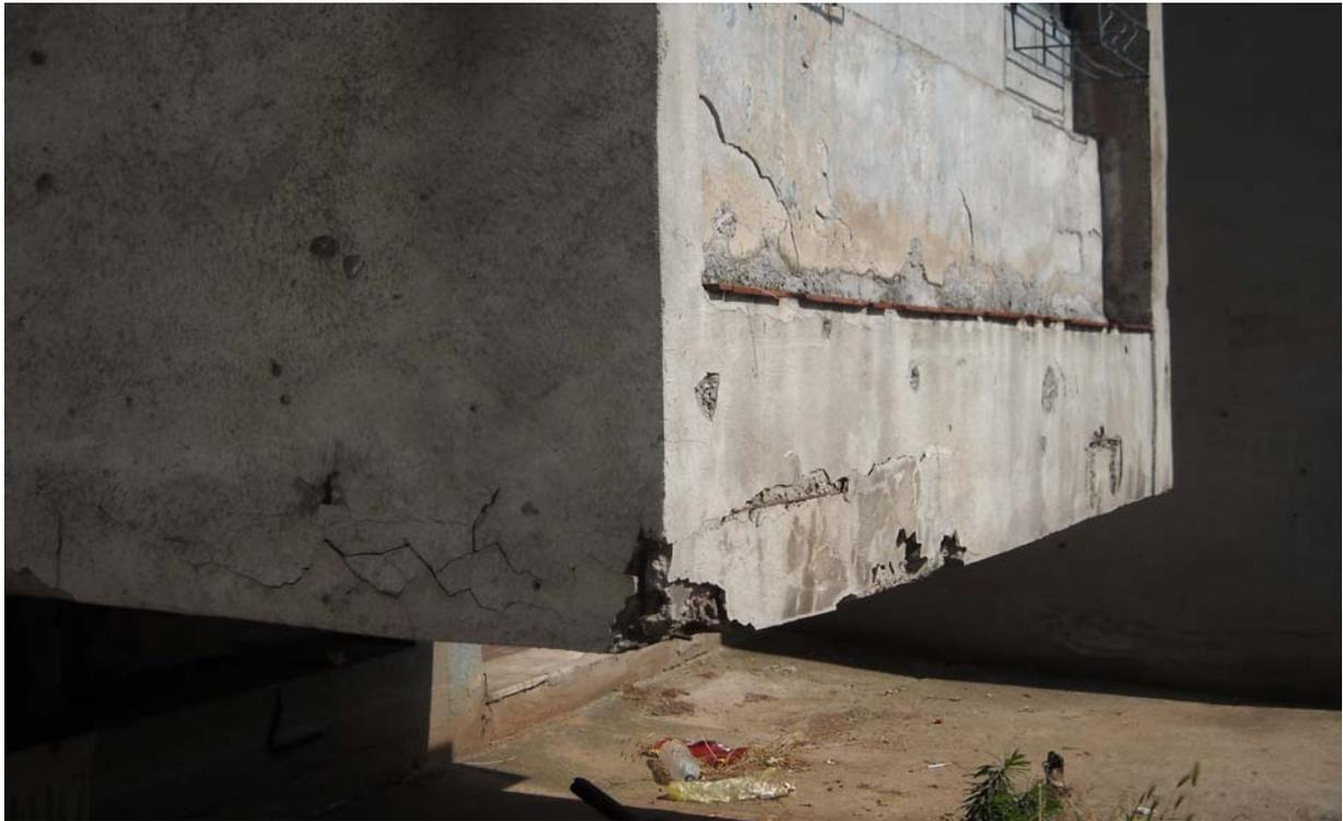
Abb. 30: Schäden an der Brüstung zufolge ungenügender Betondeckung und fehlender Blechabdeckungen (Eigene Abbildung)
