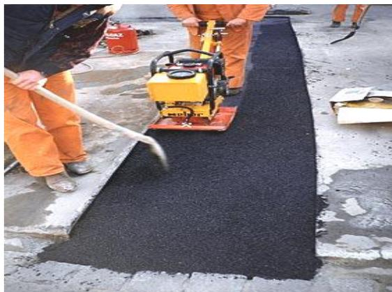
**Abbildung 18: Verdichten der Tragdeckschicht (Sabev, 2009, Seite 23)**
