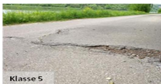
**Abbildung 7: Aufwölbung in Folge von Durchwurzeln, Klasse 5**
