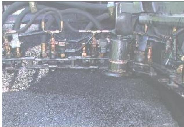
**Abbildung 21: Vorspritzen mit Bitumenemulsion (Sabev, 2009, Seite 44)**
