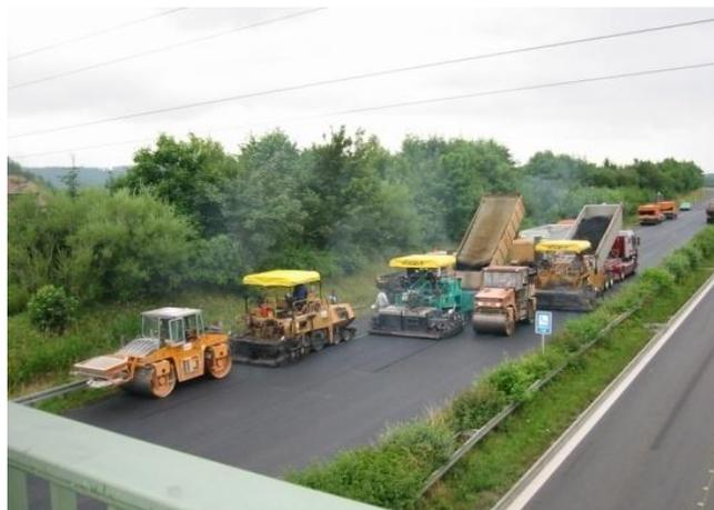
**Abbildung 22: Einbau und Verdichtung Tragdeckschicht (Sabev, 2009, Seite 44)**
