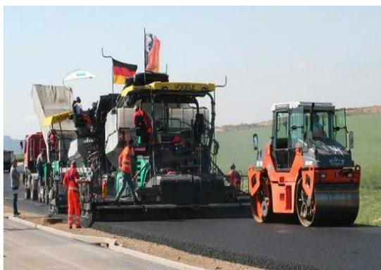
**Abbildung 20: Einbau des Mischgutes mittels Fertiger (Sabev, 2009, Seite 35)**
