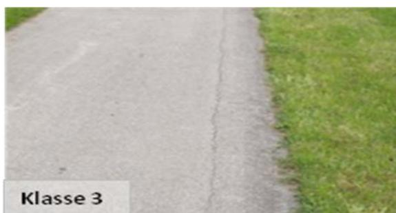
**Abbildung 11: Einzelriss in Folge mangelhafter Unterbauverdichtung, Klasse 3**
