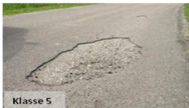
**Abbildung 9: Ausbruch in Folge mangelhaften Schichtverbundes, Klasse 5**
