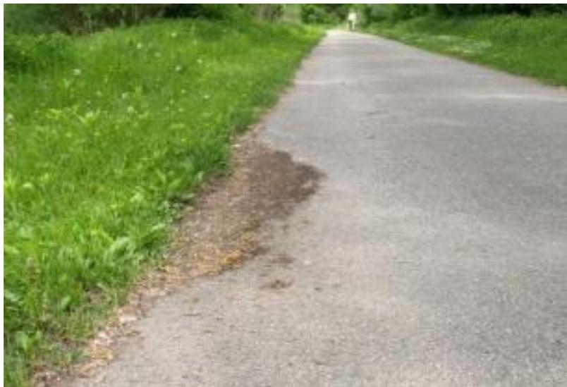
**Abbildung 10: Setzung, bereits verlegt mit Erde und Blättern**
