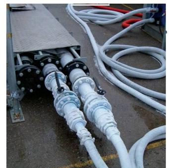
4.Anlage mit Frostschutz-/ Wassergemisch füllen
