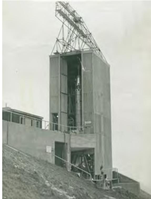
Die Rampen waren ca 19m hohe, mit Aluminium verkleidet Stahlkonstruktionen, mit sechs Serviceplattformen im Inneren. Ihre Aufgabe war es, die Raketen in die Testposition aufzurichten, gleichzeitig boten sie Schutz vor Wetter und Meeressalz.
