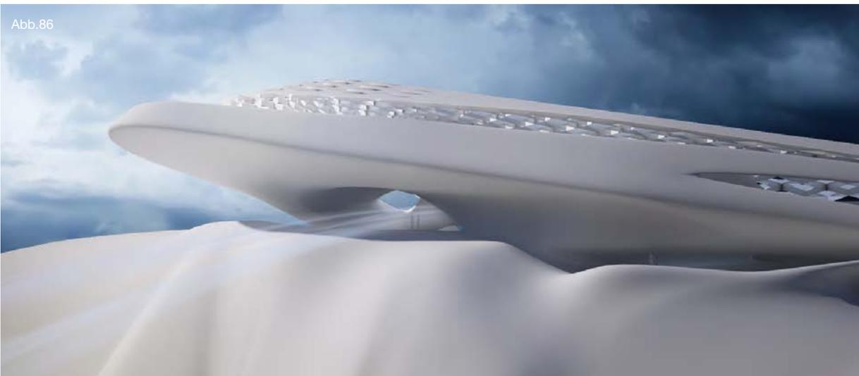
Ansicht der Windeinlassöffnung in den natürlichen Windkanal. Hier wird der Wind Richtung Atlantik eingefangen und durchs Gebäude geleitet. Der Wind unterstreicht hier die Dynamik und Geschwindigkeit der ausgestellten Raketenmodelle und erinnert an die Vergangenheit des Ortes als Testgelände.
