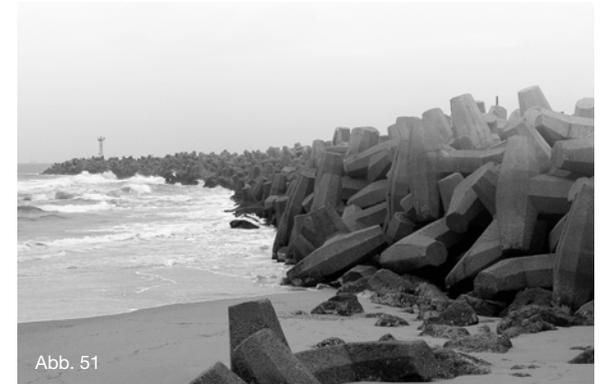
Um die Erosionsrate von ~ 0.4 m pro Jahr zu verringern und damit den Erhalt der historischen Substanz der Old und New Battery zu gewährleisten, sowie den Bauplatz langfristig (> 100 Jahre) zu sichern, ist es nötig, die marinen Einflüsse auf die Steilküste zu verringern. Dadurch kann die Erosion maßgeblich verzögert werden.
