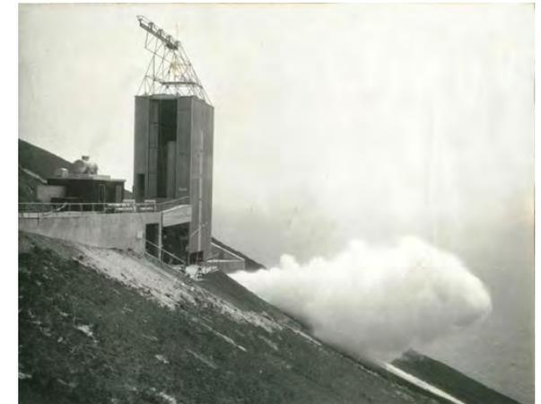
Nachdem die Rakete in der Testrampe positioniert war wurden alle Systeme überprüft und anschließend die Tests gestartet. Während der Zündung der Rakete war es nötig den Auffangbehälter unter den Triebwerken zu kühlen, dazu wurde Wasser aus einem eigenen Reservoir zum Pumpenraum und anschließend zu den Testständen gepumpt. Das verbrauchte Kühlwasser wurde anschließend aus den Testrampen hinaus, den Hang hinunter ins Meer geleitet. <sup>4</sup>
