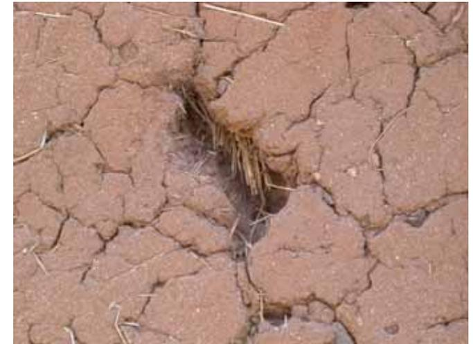
Abb 42: Oberfläche eines Lehmputzes
