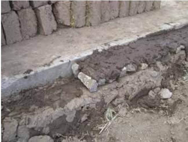
Abb 52: frisches Fundament aus Steinen, Langui, Peru
