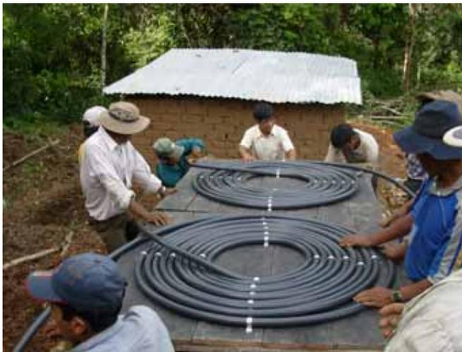
Abb 4: Montage eines Kollektors, Modell „Caracol“, Apana
