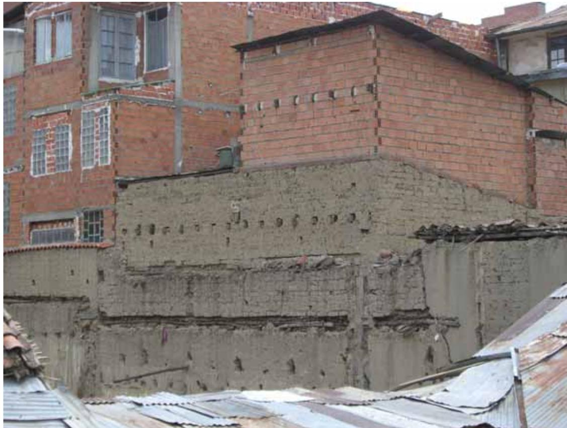
Abb 41: Ziegelmauerwerk auf Wänden aus Adobe
