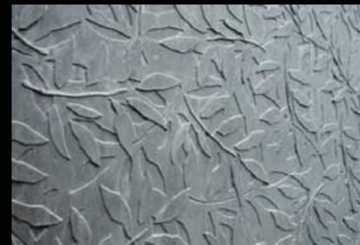
Abbildung 124: Sichtbeton mit Lorbeerstruktur
