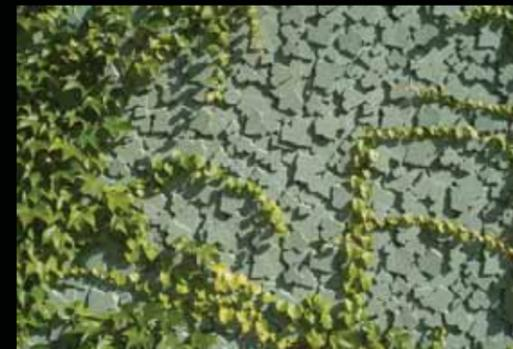
Abbildung 126: Sichtbeton mit Efeurelief an der Fassade
