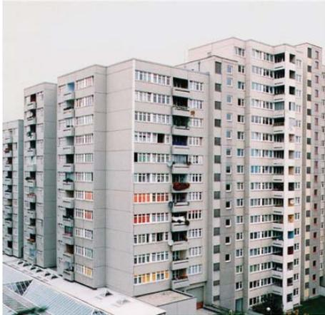
Wohnhausanlage am Rennbahnweg 27, Wien 22; architektonische Funktionalisierung, industriell angefertigte Massenbauteile und logistischer Einsatz von Kränen finden hier zu einem Höhepunkt der Rationalisierung.
