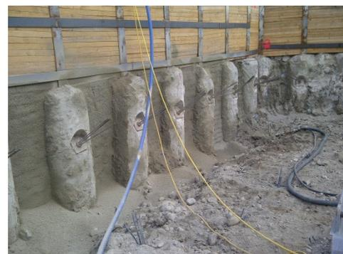
Abb. 15: Links: Gurtung einer Spundwand mit aufgesetztem Ankerkopf aus [60] und rechts: durch einfräsen vorbereiteter Sitz des Ankerkopfs bei Bohrpfählen aus [42]
