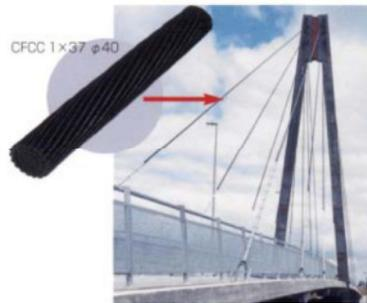
Abb. 39: Erste Schrägseilbrücke in Dänemark mit karbonverstärkten Spannkabeln aus [39]
