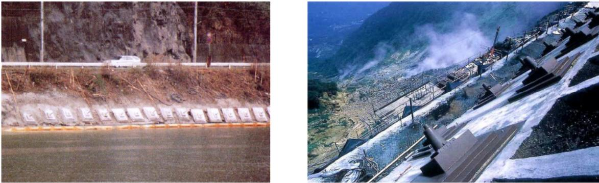
Abb. 37: Einsatz von CFK-Anker in Japan. Links mit direktem Meerwasserkontakt und rechts in schwer zugänglichem Gebiet mit stark ätzenden Einwirkungen auf die Anker aus [39]
