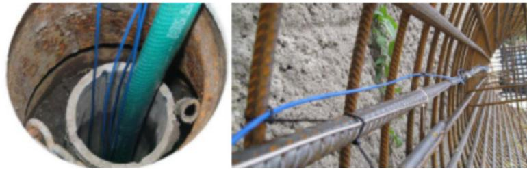
Abb. 61: Sensorkabel (blau) zur Überwachung eines Bohrlochs z.B.: für Setzungsmessungen links und rechts
