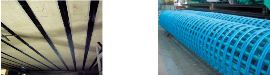
Abb. 1: Anwendungsbeispiel von CFK- Lamellen als Deckenverstärkung und rechts ein GFK- Bewehrungskorb für Bohrpfähle aus [43][41]
