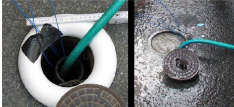
Abb. 69: Widerinstandsetzung einer Inklinometermessstelle durch faseroptische Sensoren; links: die Installation der Sensoren und rechts: Verfüllung mit Zement-Bentonit-Suspension aus [20]
