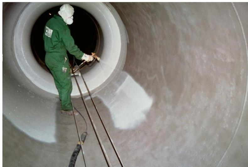
Abb.28. Das Einbringen von Schutzschicht
