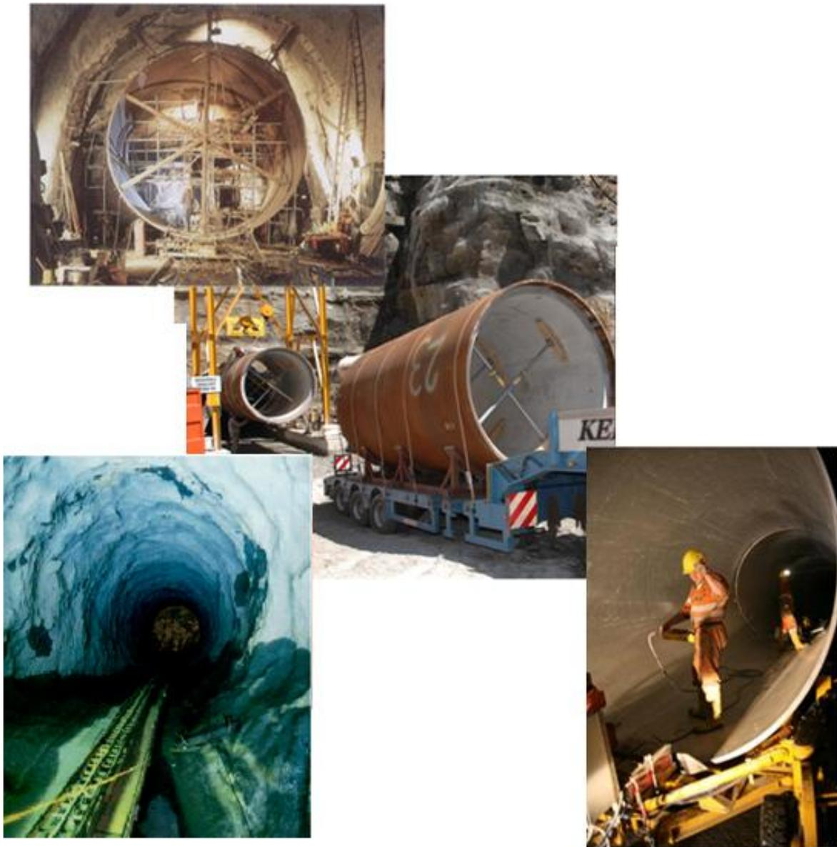
Abb.26. Panzerung des Druckstollens
