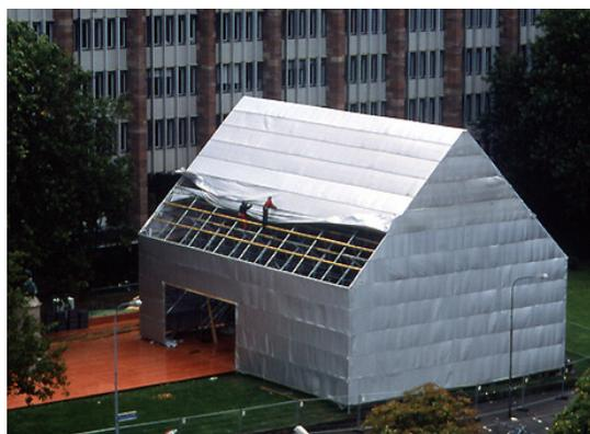
Abb. 16: Dacheindeckung mit aluminiumbedampften Stoffbahnen
