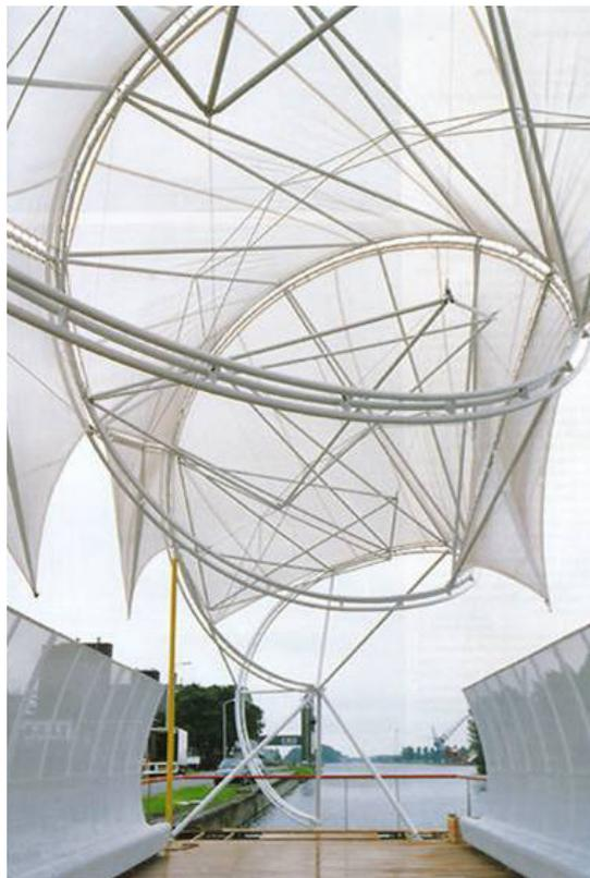
Abb. 34: Dachkonstruktion aus zwei ineinander laufenden Spiralen
