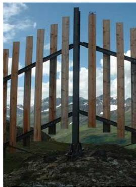
Abbildung 10: Detail eines Lawinenzauns<sup>159</sup>
