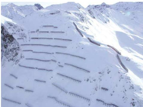
Abbildung 14: Stahlschneebrücken am Hang, am Grat sind Lawinenzäune zu sehen<sup>164</sup>
