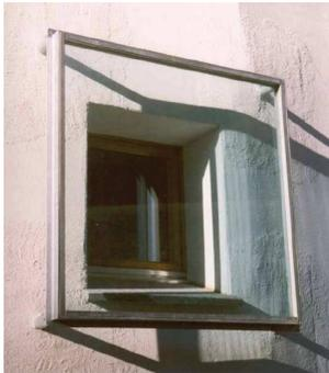
Abbildung 28: Lawinensicheres Fenster durch besondere Verglasung<sup>184</sup>
