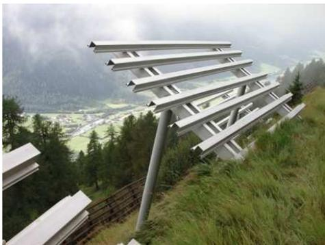
Abbildung 18: Schneeverbauung aus Aluminium (im Hintergrund aus Stahl)<sup>171</sup>
