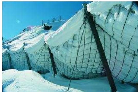
Abbildung 19: Schneenetze mit großen Schneemengen<sup>172</sup>
