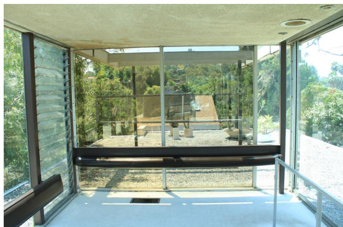
**Bild 100** Schiebefenster auf vorgelagerter Schiene im Außenraum, Obergeschoß, VDL-Haus
