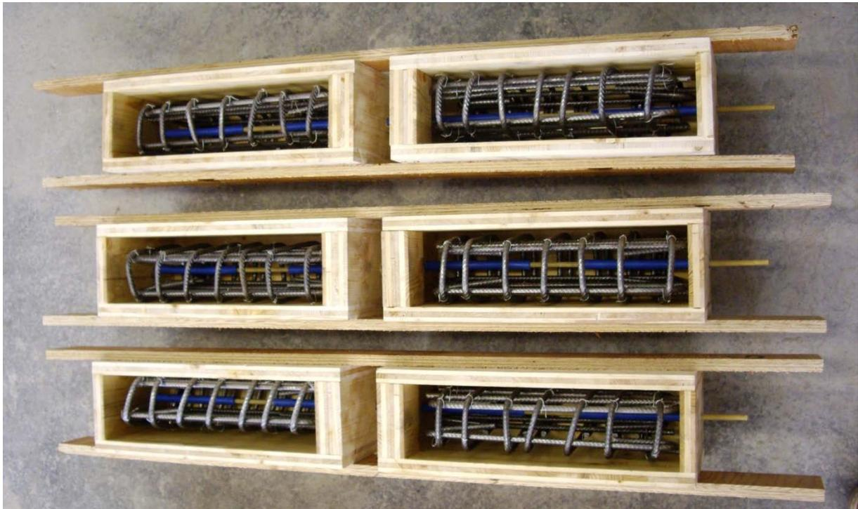
Abbildung 5.11: Fertiggestellte Probe zum betonieren
