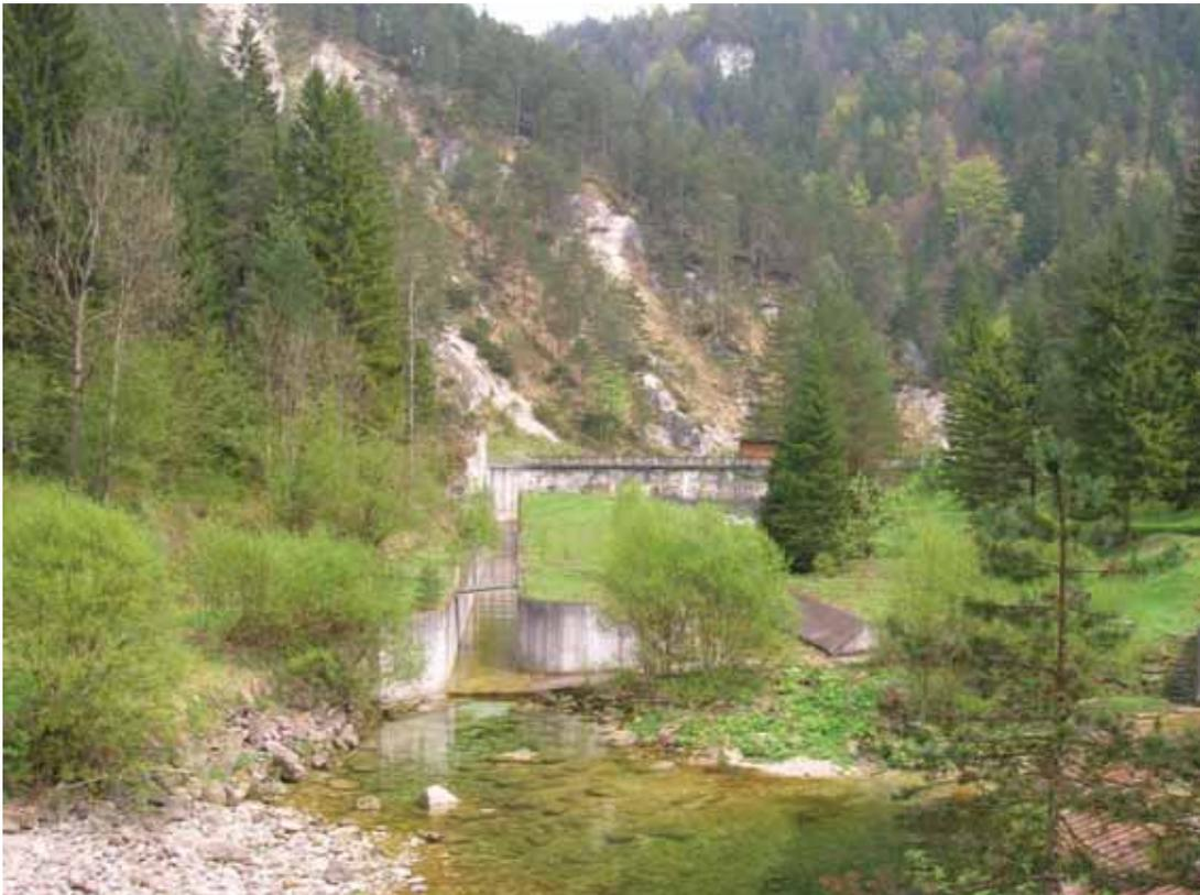
Abb. 40 Foto des Kanals der Hochwasserentlastung I (links im Bild) und des Kanals des Grundablasses. Rechts unten im Bild ist der Holzboden der Hochwasserentlastung II zu erkennen. Im Bildvordergrund befindet sich der Naturkolk. Blick flussaufwärts Richtung Stau-mauer. (Kozumplik, 2011)
