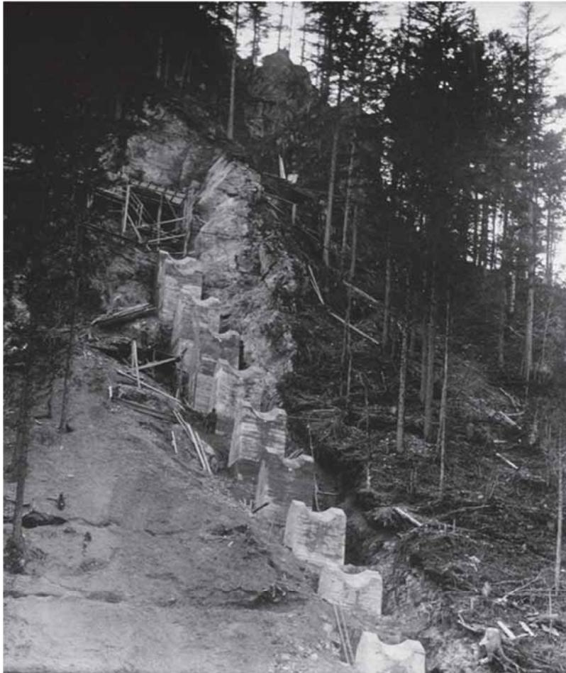
Abb. 7 Foto vom Bau der Fundamente für die Druckrohrleitung (P 2021)
