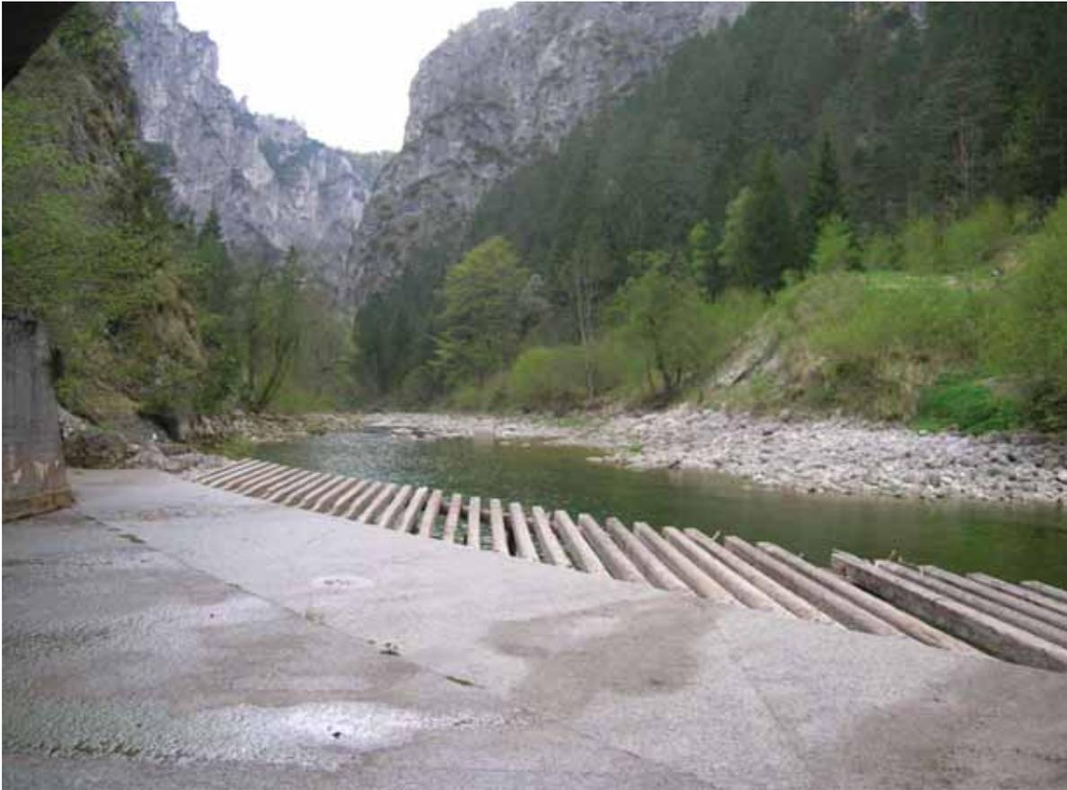
Abb. 36 Foto des hölzernen Schussbodens am Übergang zur unbefestigten Flusssohle mit Naturkolk (Kozumplik, 2011)
