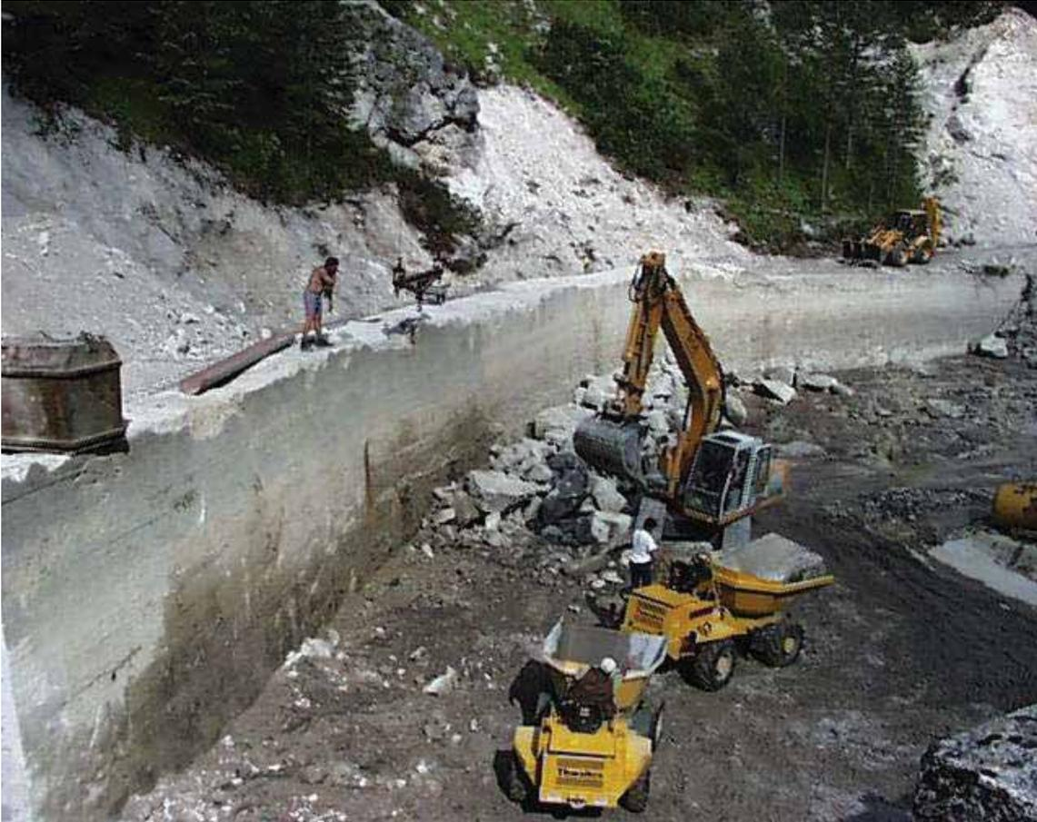
Abb. 11 Baustellenfoto vom Bau der zusätzlichen Hochwasserentlastung - Streichwehr (EVN-Archiv)
