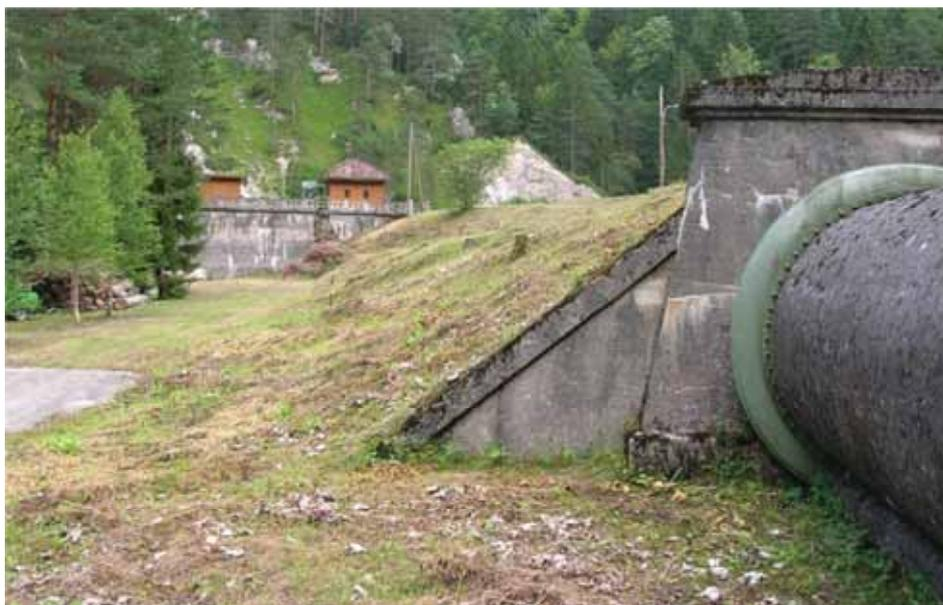
Abb. 42 Foto des Übergangs vom erdverlegten Druckrohr (im Erddamm) zur Rohrbrücke mit Staumauer im Hintergrund (Kozumplik, 2012)
