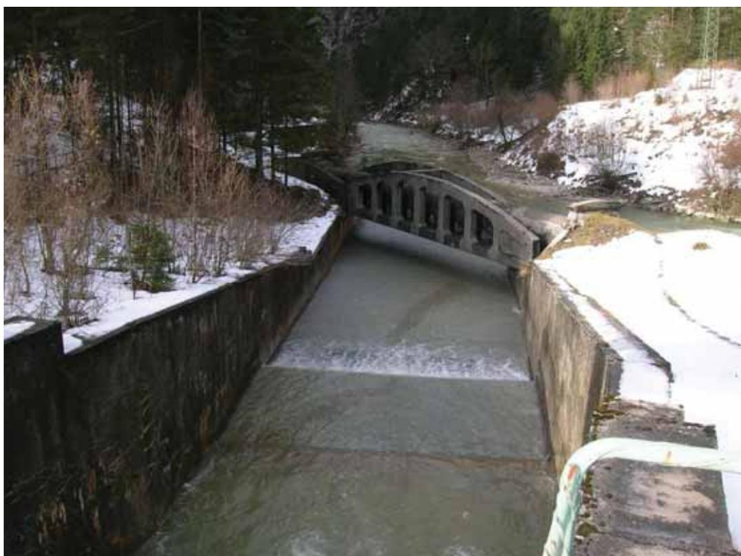
Abb. 35 Foto Hochwasserentlastungskanal mit Rohrbrücke bei leichtem Überlauf (Kozumplik, 2013)
