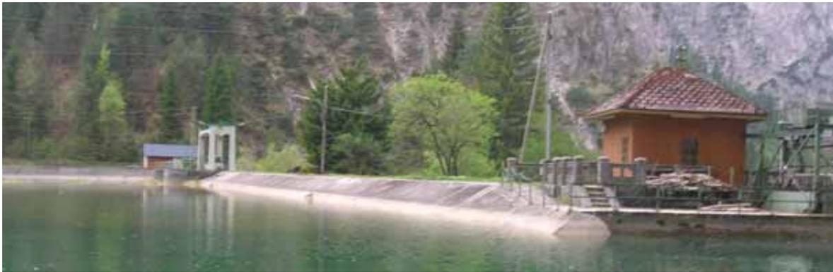
Abb. 30 Foto des Dammes mit der Obergewichtsklappe im Anschluss an die linke Talflanke. Im Vordergrund ist der Triebwassereinlauf zu sehen. (Kozumplik, 2011)
