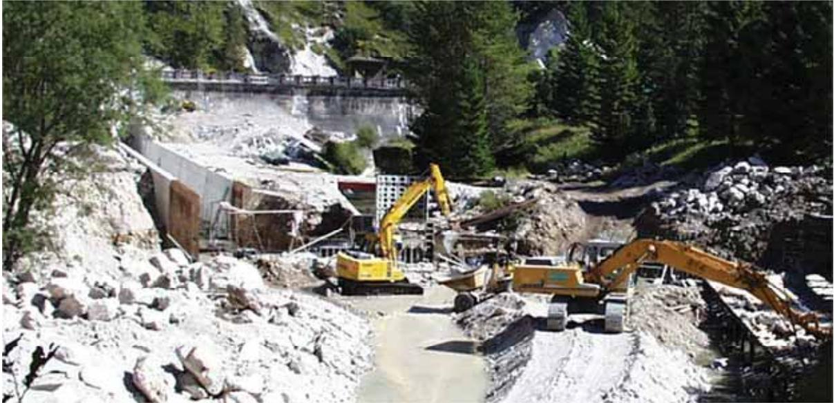
Abb. 10 Foto vom Bau der zusätzlichen Hochwasserentlastung - Unterwasserkanal (EVN-Archiv)
