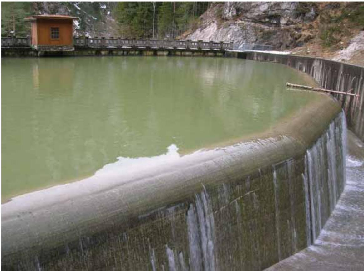
Abb. 37 Foto des Streichwehres und der Sammelrinne am rechten Ufer bei leichtem Überlauf. Im Hintergrund ist die Gewichtsmauer zu sehen. (Kozumplik, 2013)
