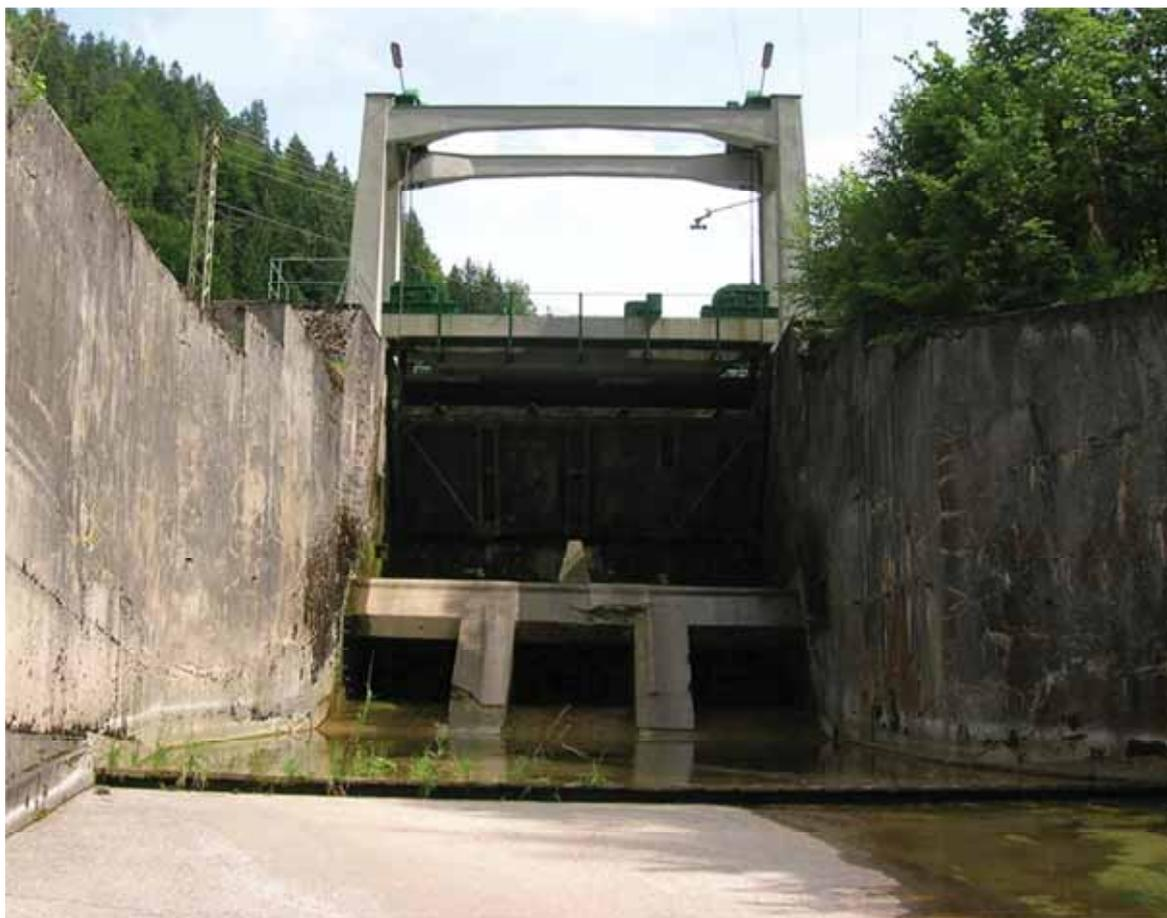
Abb. 34 Foto Hochwasserentlastungskanal mit Kiesgassen und Obergewichtsklappe (Kozumplik, 2012)
