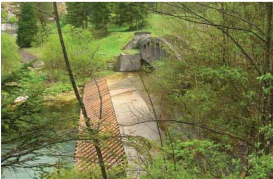
Abb. 45 Foto der Rohrbrücke über den Kanal der Hochwasserentlastung I. Links ist der hölzerne Schussboden der Hochwasserentlastung I und der Naturkolk zu sehen. (Kozumplik, 2011)
