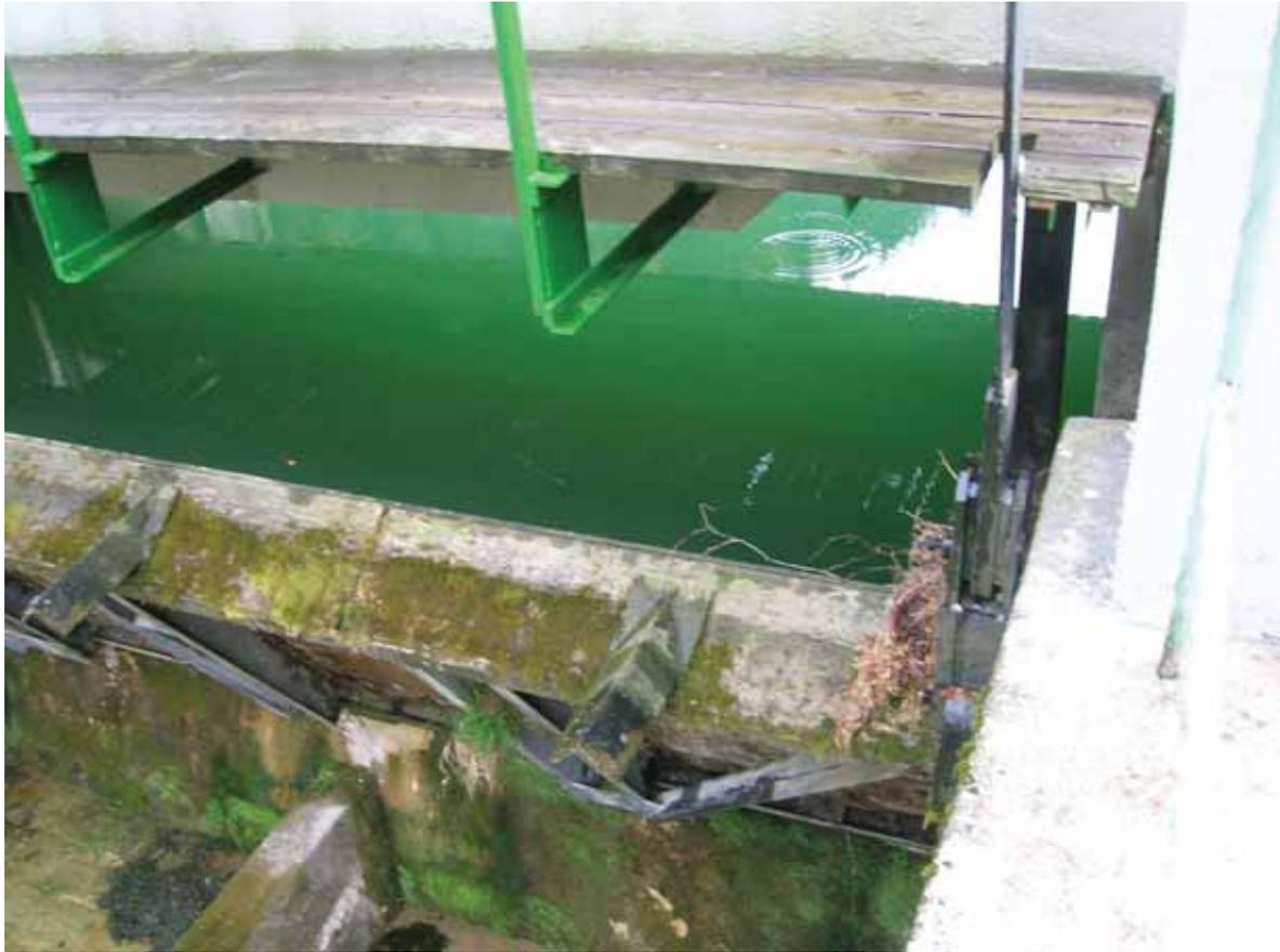
Abb. 32 Foto Obergewichtsklappe mit Wartungssteg (Kozumplik, 2011)
