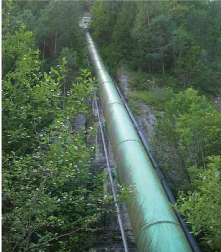
Abb. 50 Foto der Druckrohrleitung vom Krafthaus aus gesehen. Am oberen Bildrand ist die Apparatekammer zu erkennen. (Kozumplik, 2011)
