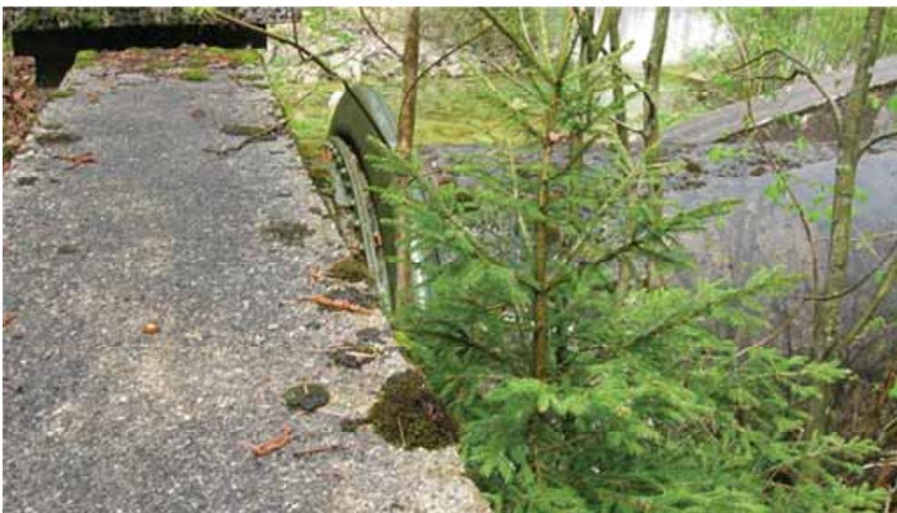
Abb. 47 Foto des Übergangs vom Druckrohr (Rohrbrücke) zum Druckstollen (Kozumplik, 2011)
