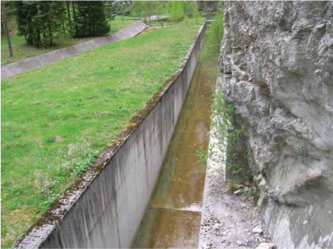
Abb. 39 Foto des Kanals der Hochwasserentlastung. Links im Bild verläuft der Kanal des Grundablasses. Blick Richtung Unterwasser. (Kozumplik, 2011)
