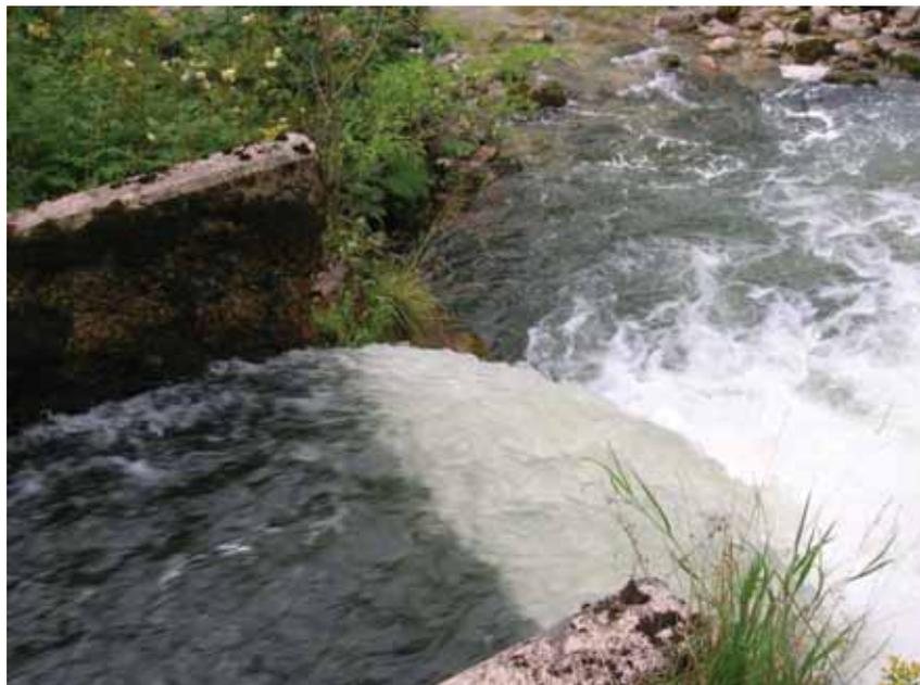
Abb. 73 Foto Auslaufbereich KW Wienerbruck, freier Überfall in die Erlauf mit Kolk
