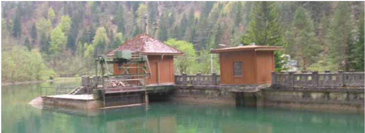
Abb. 27 Foto des Triebwassereinlaufes mit dem Einlaufrechen (linkes Gebäude) am Übergang von der Mauer zum Damm. Das rechte Gebäude beinhaltet die Bedienungselemente der Grundablassverschlüsse. (Kozumplik, 2011)
