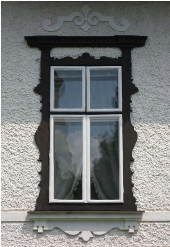
Abb. 67: Pfostenstockfenster mit nach außen aufschlagenden Fensterflügeln
