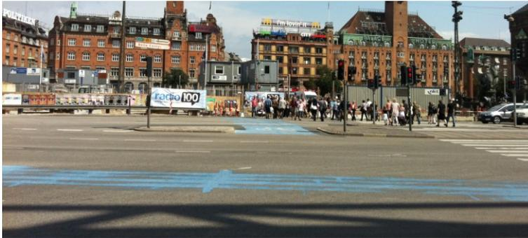
In Fahrtrichtung Rødovre erreicht Abschnitt 1 einen Zielerreichungsgrad von 86 %. Lediglich die Sichtbarkeit der Bodenmarkierungen und die Verkehrsbehinderungen durch die Tourismusbusse sind negativ anzumerken. Der Radweg wird hier in einer komfortablen Breite geführt und durch Radabstellbügel vom Kfz-Verkehr getrennt. Die Sichtweiten sind aufgrund des breiten Straßenquerschnitts ohne Bepflanzung und parkende Kfz sehr gut und Gefahrensituationen können schon weit im Voraus erblickt werden.
