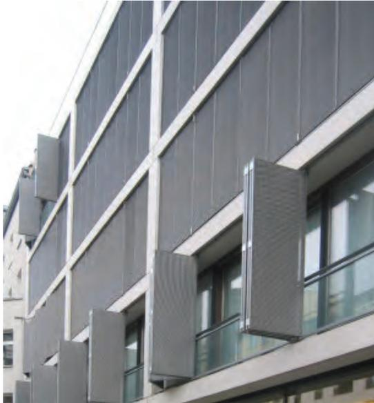
Abbild. 91 @Faltschiebeläden, <http://www.baunetzwissen.org>
