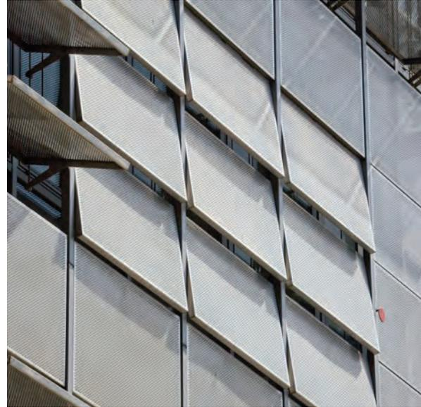
Abbild. 92 @Faltschiebeläden, <http://www.baunetzwissen.org>
