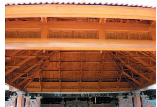
**ABB.325:** Dachkonstruktionen aus Holz mit geschnitzten hinduistischen Motiven und Säulen aus der *Majapahit*-Ära
