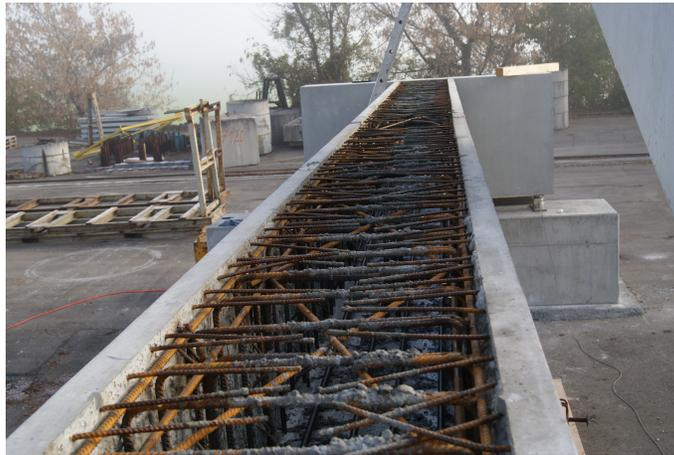
Abbildung 21: halber Versuchsträger während der Herstellung
