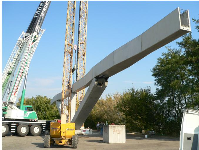
Abbildung 3: Einsatz von Fertigteilen beim Brückenklappverfahren
