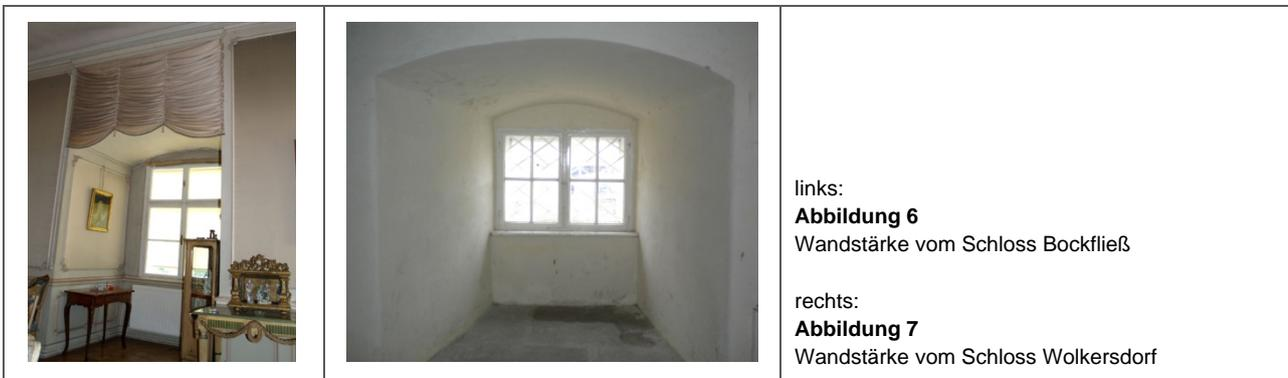
Diese verjüngen sich um die Deckenauflegerbreite nach oben hin. Aufgrund der Bauweise mit Holztramdecken und Dippelbaumdecken, waren die Spannweiten der Räume vorgegeben mit 6-9 m Breite. In der Länge findet man je nach ursprünglicher Nutzung verschiedene Dimensionen. Als Grunddimension für einen Aufenthaltsraum kann man von 8-10m ausgehen. Die Raumhöhen lagen bei 4-5m in normalen Räumen, bis hin zu 12m bei Festsälen oder in den Kapellen, die auch oft eine Kuppeldecke hatten.
