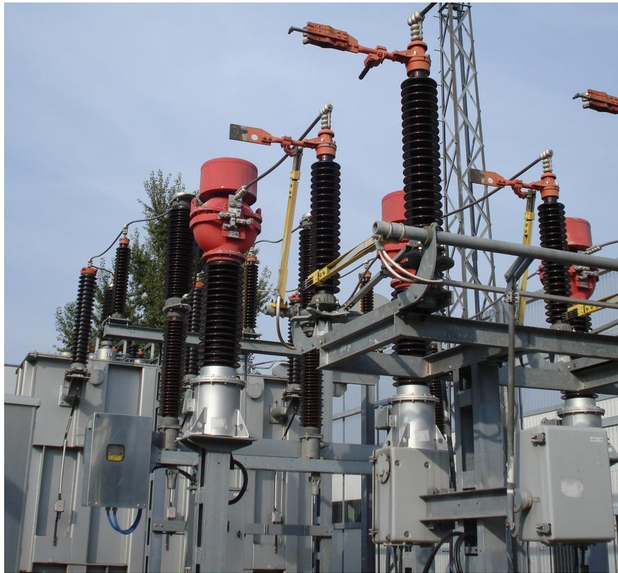
Abbildung 2.4: 110 kV Anspeisung und Mittelspannungstransformator M850
