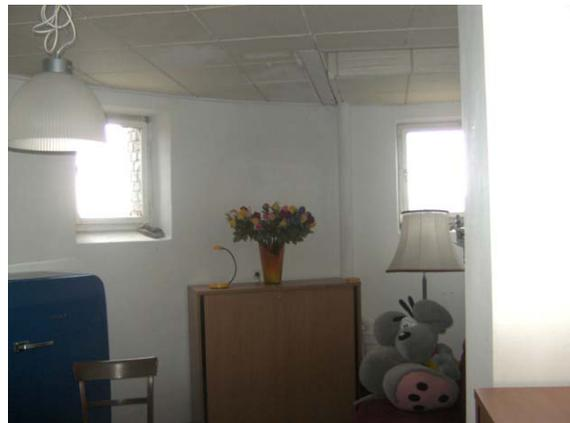
Abb. 145a-b: Erste Etage - eingezogene Zwischendecke, dadurch geringere Raumhöhe und kleinere Fenster
