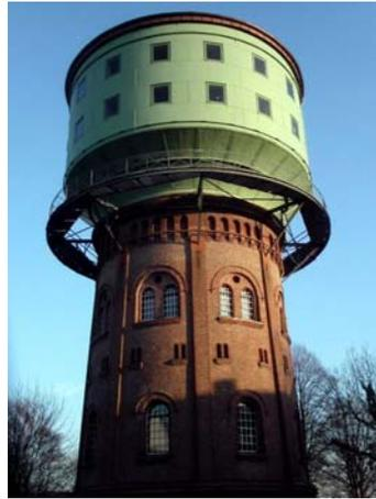
Abb. 14: Wasserturm Essen-Steele, Turmschaft mit Rundbogenfries im Stil des Historismus und sichtbarem Wassertank aus Stahlblech
