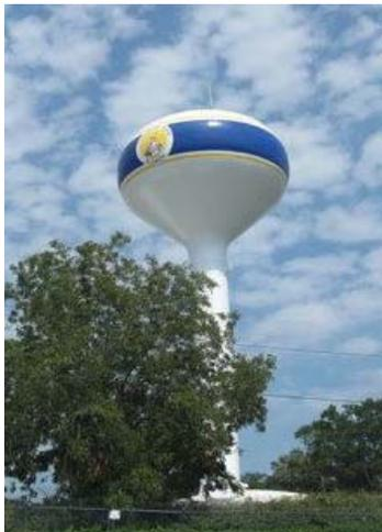
Abb. 51: Sphäroidischer Behälter,
