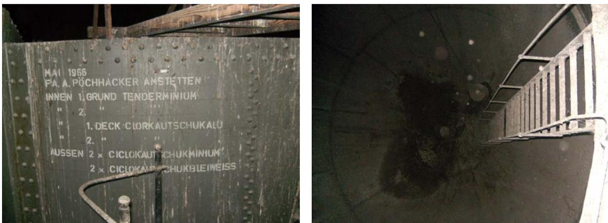
Abb. 152a-b: Genieteter Hängebodenbehälter aus Eisenblech - Leiter ins Innere des Wasserbehälters
