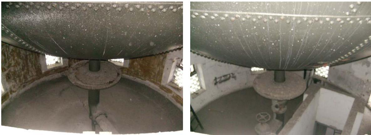
Abb. 146a-b: Die beiden Wasserbehälter mit je 150 m<sup>3</sup> Rauminhalt
