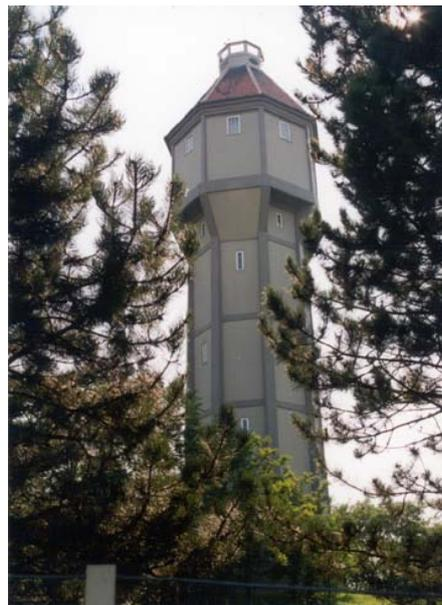
Abb. 17: Wasserturm des Luftschifffahrtskommandos Fischamend (1916) - Stahlbetonskelettkonstruktion mit Ziegelausfachung
