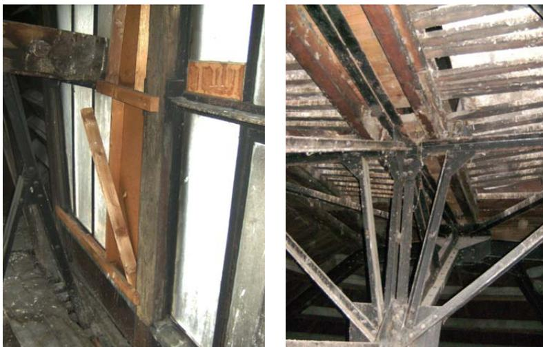
Abb. 157a-b: Schadhafte Fenster - Untersicht des Laternenbodens
