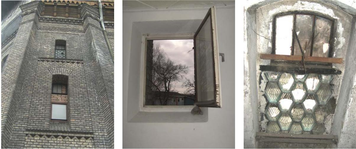
Abb. 134a-b-c: Teilweise zugemauertes Fenster im OG 1 - Beschädigtes Fenster mit kaputter Oberlichtöffnung
