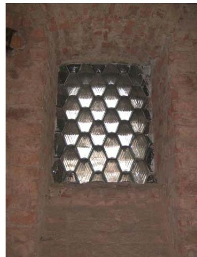
Abb. 133a-b-c: Noch erhaltene Fenster mit Glasbausteinen, Außen- und Innenansicht
