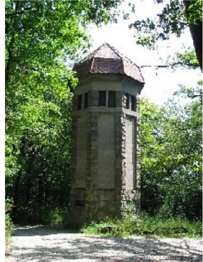
Abb. 10: Standrohrturm am Michaelerberg mit einem Behälter von ca. 90 m<sup>3</sup> Nutzinhalt
