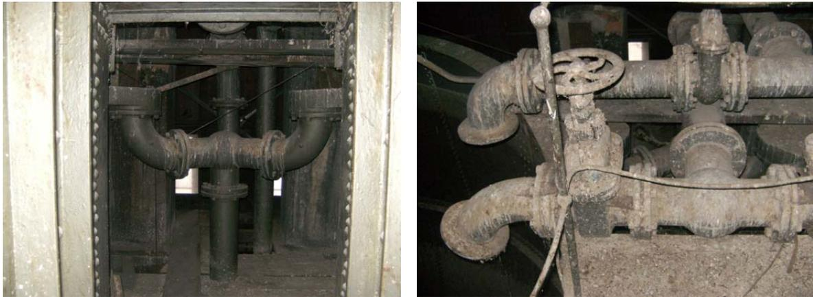
Abb. 153a-b: Noch vorhandene Rohre und technische Einrichtungen zur Befüllung der Wasserbehälter
