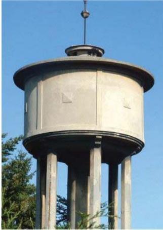
Abb. 13: Wasserturm des k. u. k. Militärlagers Korneuburg, Wasserbehälter auf Stahlbetonstützen
