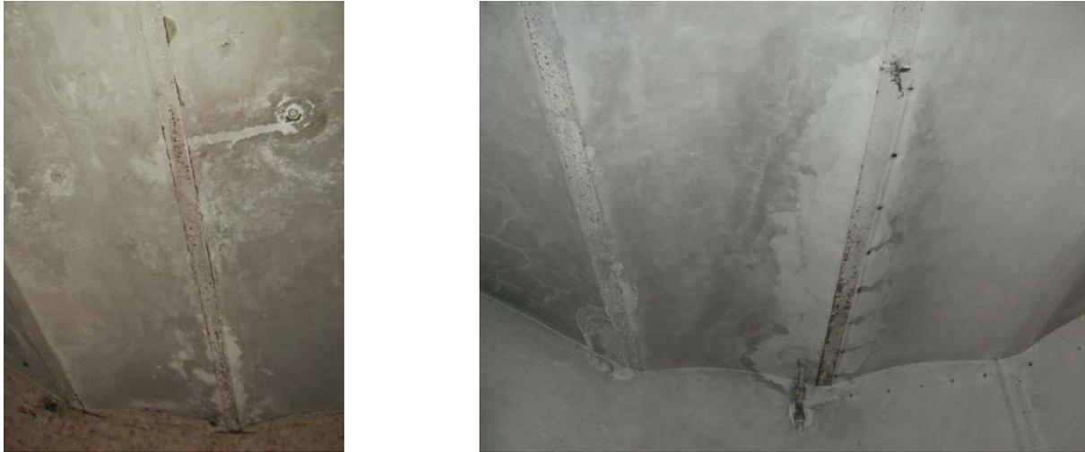
Abb. 139a-b: Platzlgewölbe über Parterre und OG 1
