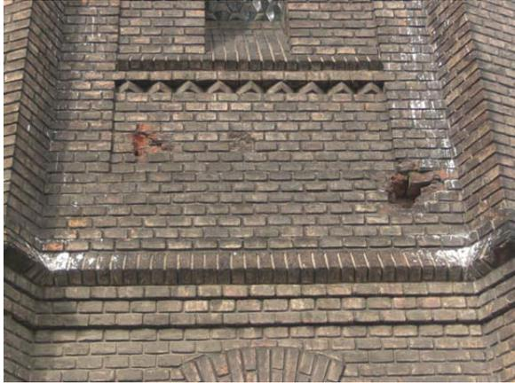
Abb. 125: Einschusslöcher an der Südfassade
