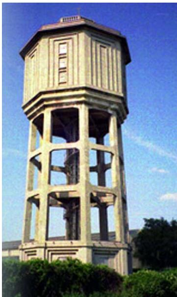
Abb. 16: Wasserturm der ehemaligen Sprengmittel- und Pulverfabrik Blumau (1916/17) - in Eisenbetonskelettkonstruktion
