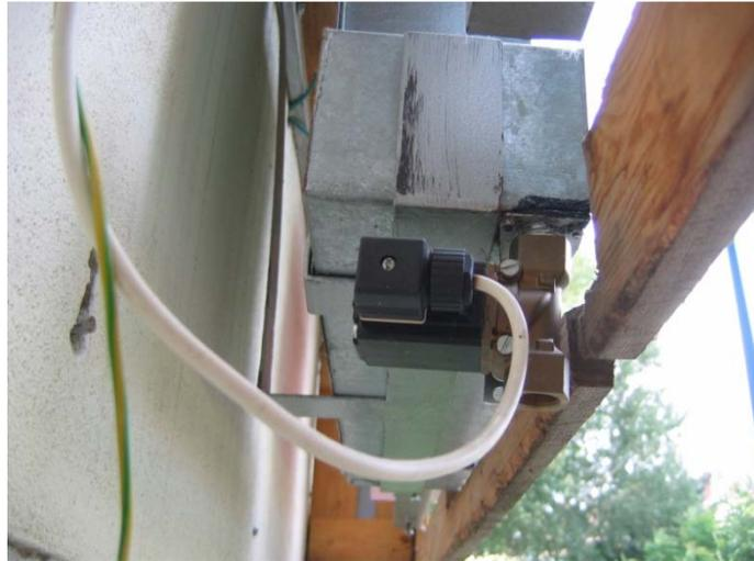
Abb. 18 – Ventil für Wasserablauf aus der Auffangwanne
