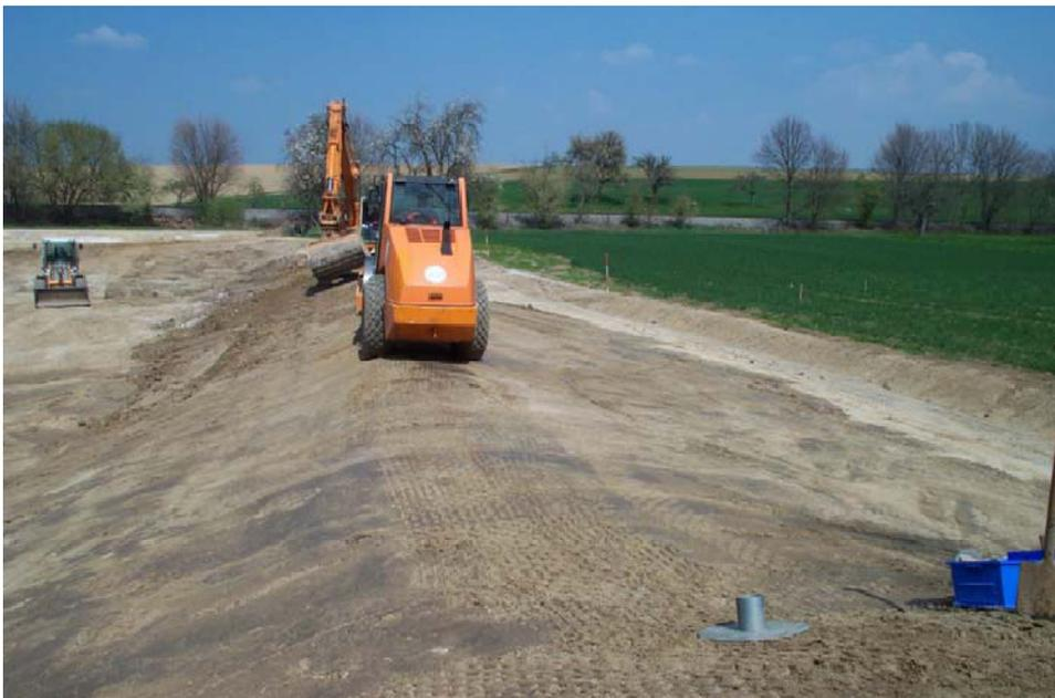
**Abbildung 3.22:** Überströmbare Dam aus einer Bodenverfestigung.[26]
