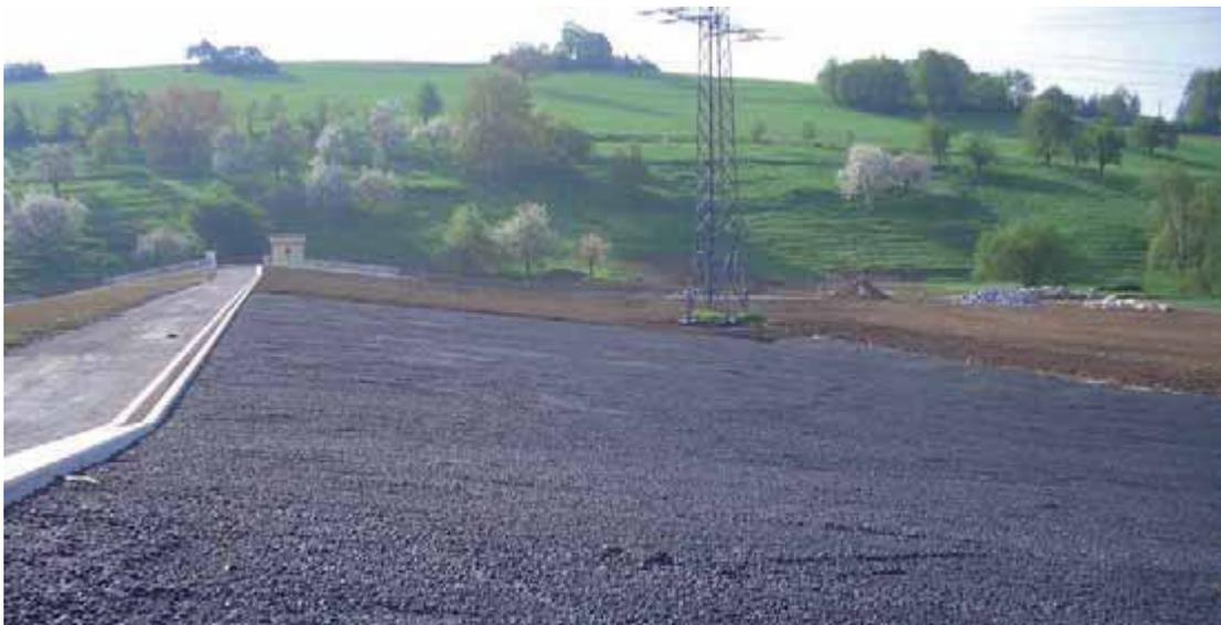
**Abbildung 3.15:** Mastix-Schotter-Deckwerk am HRB Mönchzell bei Meckenheim des Zweckverbandes Hochwasserschutz Einzugsbereich Elsen-Schwarzbach vor der Begrünung [21]
