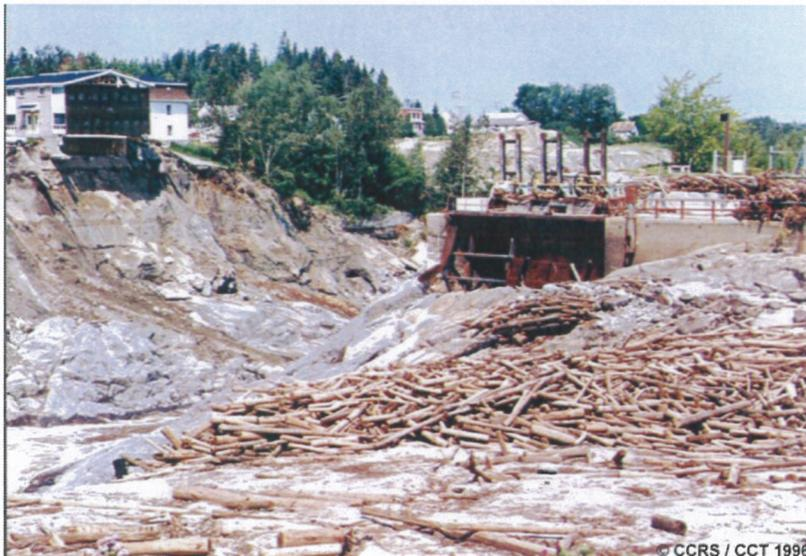
**Abbildung 1.1:** Bruch eines Dammes durch Überströmung [CCRS/CCT1996)
