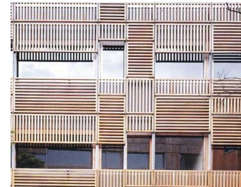
Abb. 155 Bsp. Sonnenschutzlamellen aus Holz
