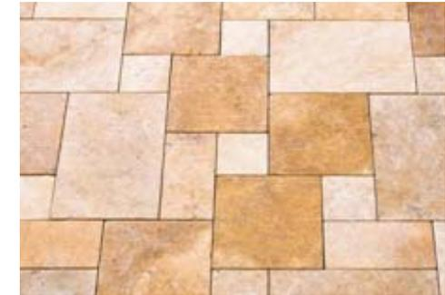
Abb. 149 Bodenplatten aus Travertin in römischem Verband
