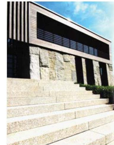
Abb. 162 IGZ Softwarescheune in Falkenberg, Brückner& Brückner Architekten, Fassade mit Krustenplatten
