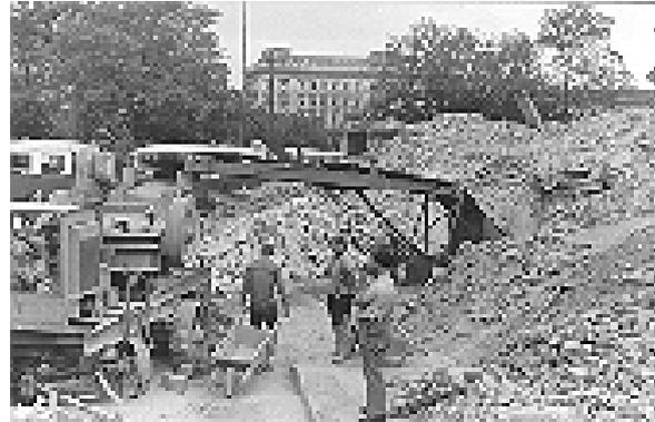
Abb. 11: Ziegelherstellung aus Bauschutt, 1947
