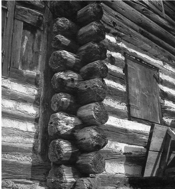
*Abb. 43: Ausgestopfte Fugen eines Blockverbandes*
