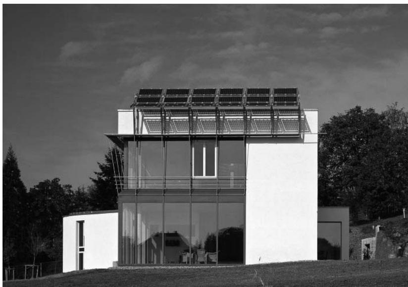
Abb. 26: Passivhaus mit aufgeständerten Sonnenkollektoren
