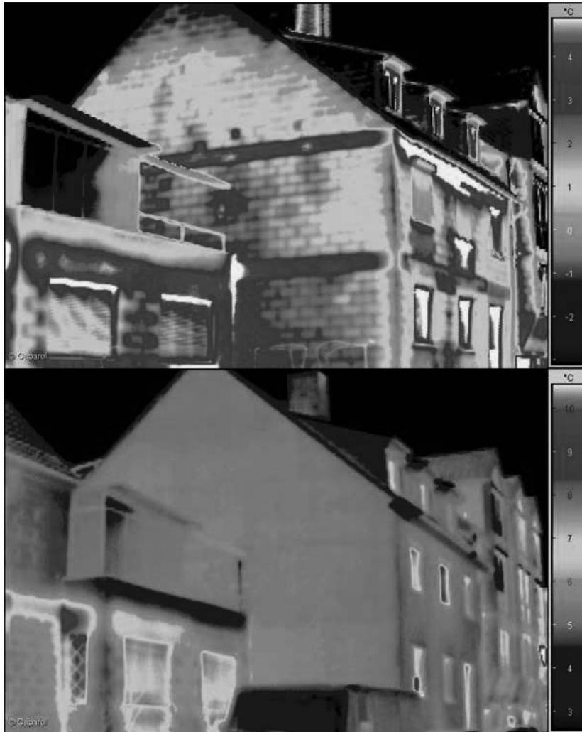
Abb. 17: 2 Aufnahmen mit einer Wärmebildkamera: oben vor, unten nach der thermischen Sanierung
