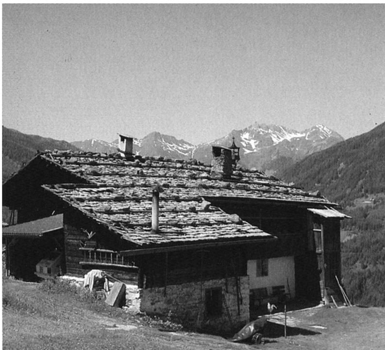
*Abb. 39: Legschindeldach beim Feuchterhof in Luttach (17. Jh.)*
