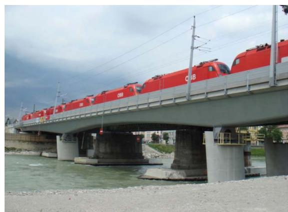
Abb. 1.5: Belastungsprobe einer Verbundbrücke über die Salzach bei Salzburg
