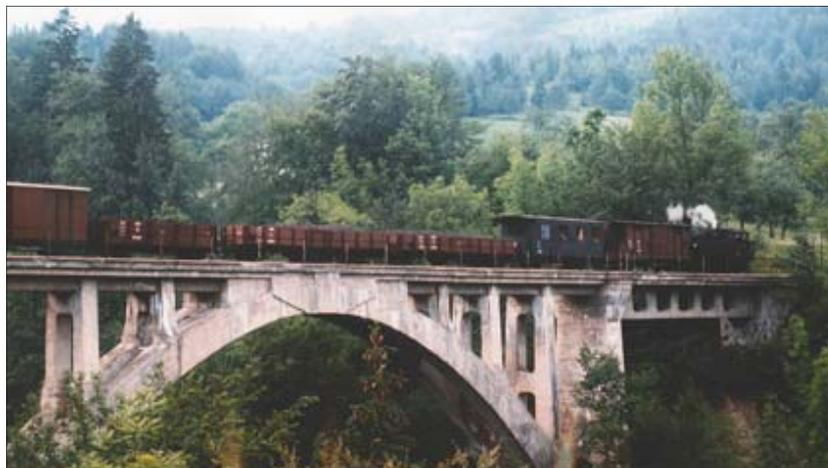
**Abb. 1.3: Bogenbrücke über die Steyrling, Baujahr 1908, Stützweite 79,1 m**
