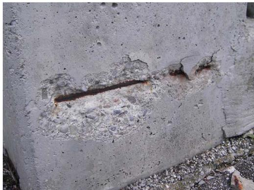
**Abbildung 2.11: Schadensbild einer Carbonatisierung von Beton**
