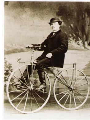
Als Vorbild diente die Laufmaschine von Drais. Durch das anbringen einer Kurbel mit Pedalen am Vorderrad konnte eine effizientere Fortbewegung erzielt werden. Der Franzose Pierre Lallement gilt als einer von vielen Erfindern, die diese Art der Konstruktion forcierten.
