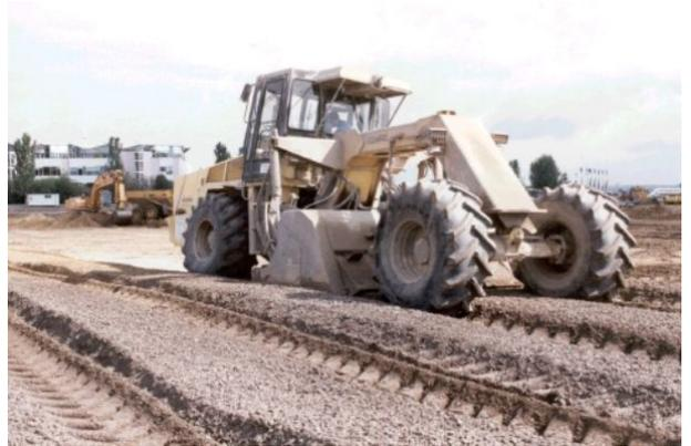
Abb. 14: Erdarbeiten zur Vermischung
