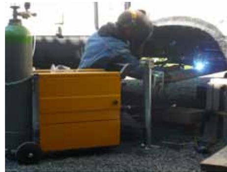
Abb.138 Anschweißen der Rohre am Auflager
