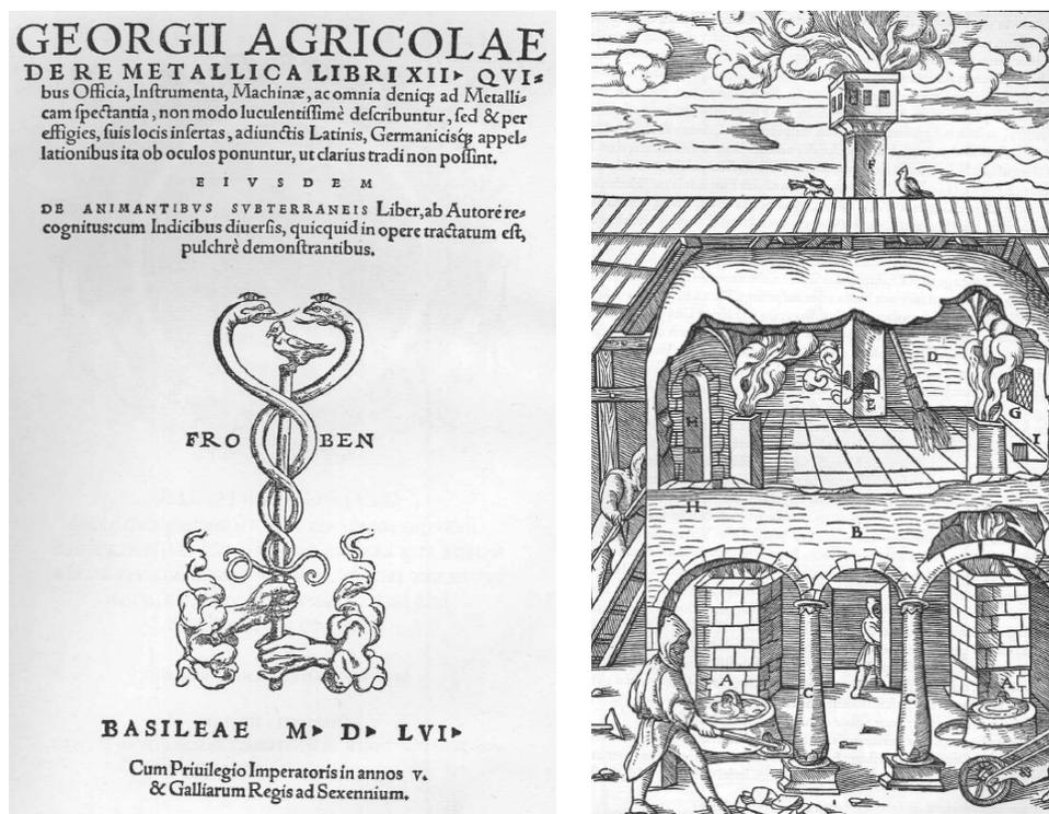
Abb. 1.1: Titelseite und Flugstaubkammer aus G. Agricola „De re metallica libri XII“
