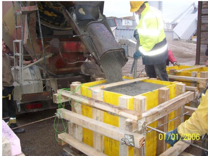
*Bild 6.4: Einbau und Verdichtung des Betons*
