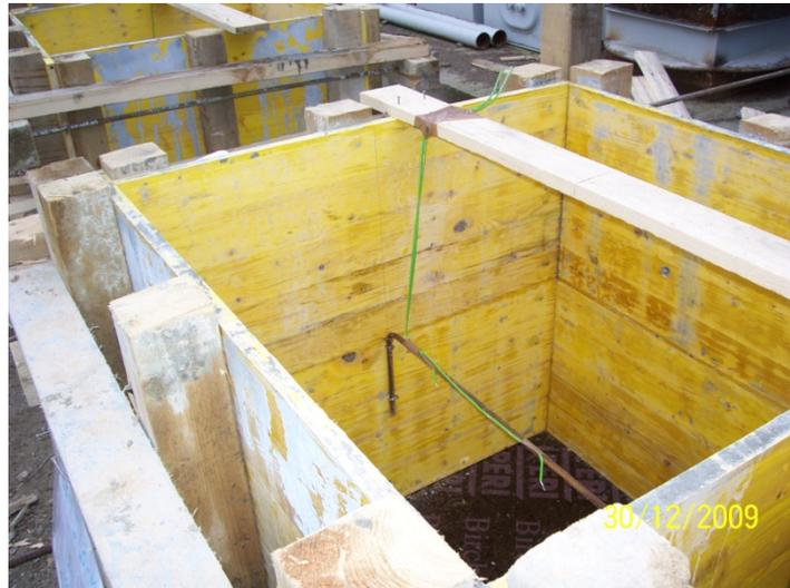
*Bild 6.8: Einbau der Temperaturfühler*
