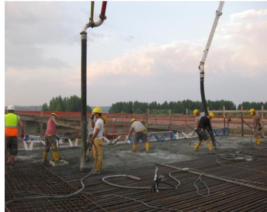
*Bild 5.8: Betontransport und Einbau*
