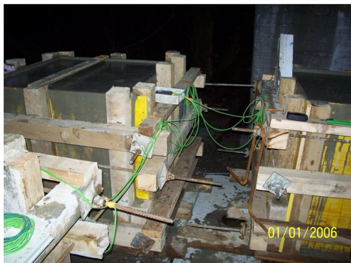
*Bild 6.5: Anschluss der Datenlogger*
