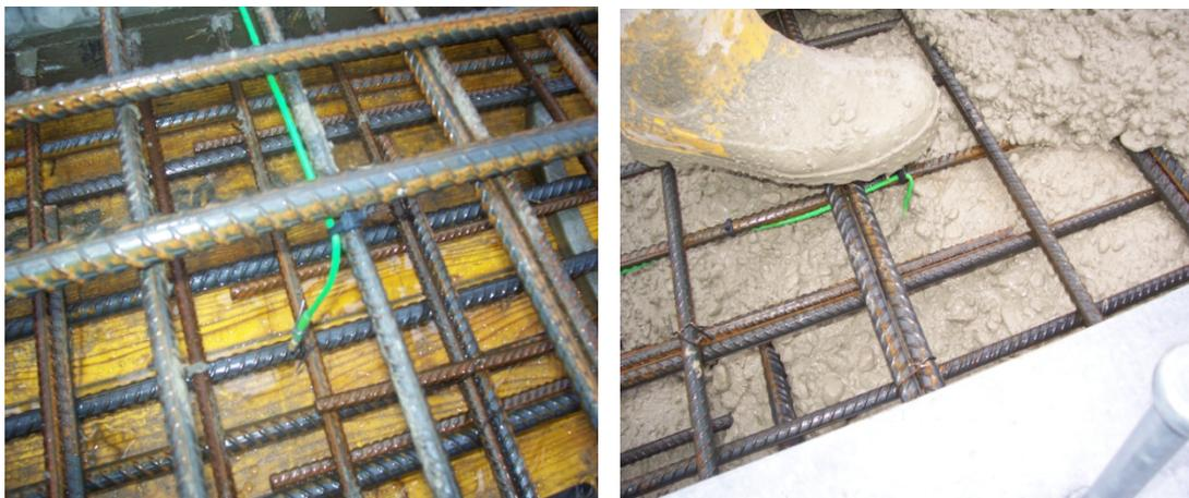
*Bild 5.7: Einbau der Temperaturfühler*
