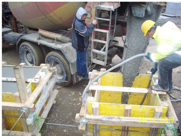
*Bild 6.9: Herstellung den Versuchskörpern*
