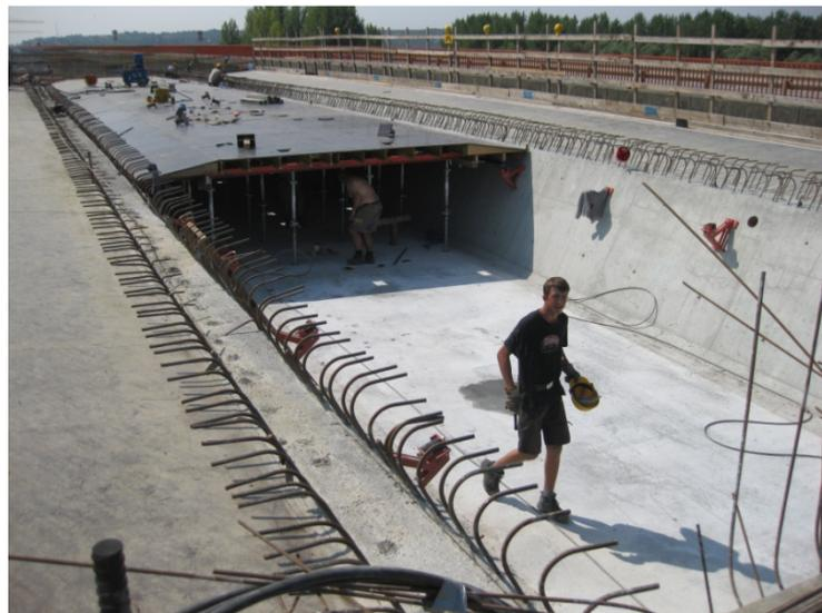
Bild 5.5: Schalung der obere Platte nach Fertigstellung der untere Platte
