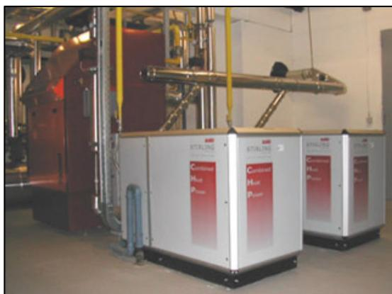
Bild 22: Solo Stirling 161 microKWK-Modul im Stuckitzbad in Graz<sup>16</sup>
