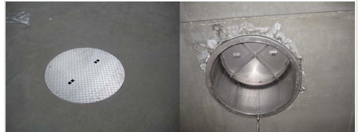
Abb.25. Detaillösung für Gefälletransport im Weingut Gernot Heinrich
