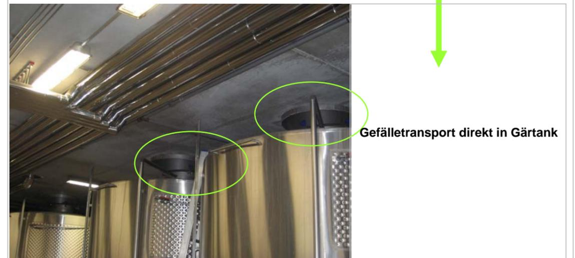
Abb.26. Detaillösung für Gefälletransport im Weingut Gernot Heinrich
