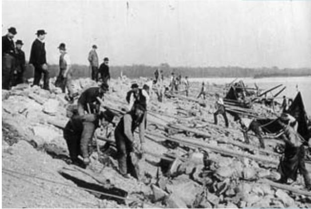
Abb. 66.: Befestigungsarbeiten am neuen Ufer zum Schutz gegen Auswaschungen
