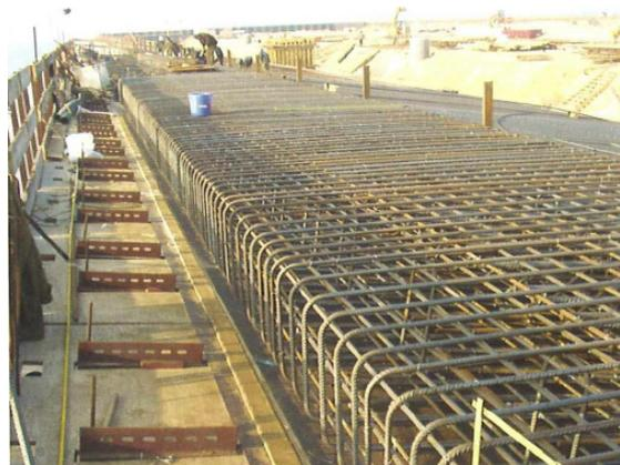
Abbildung 3.25: Containerterminal Bremerhaven Bewehrung Kajenkopf [45]
