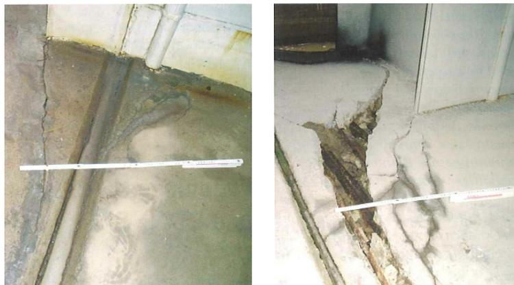
Abbildung 3.23: Containerterminal Bremerhaven schadhafte Fugen [45]
