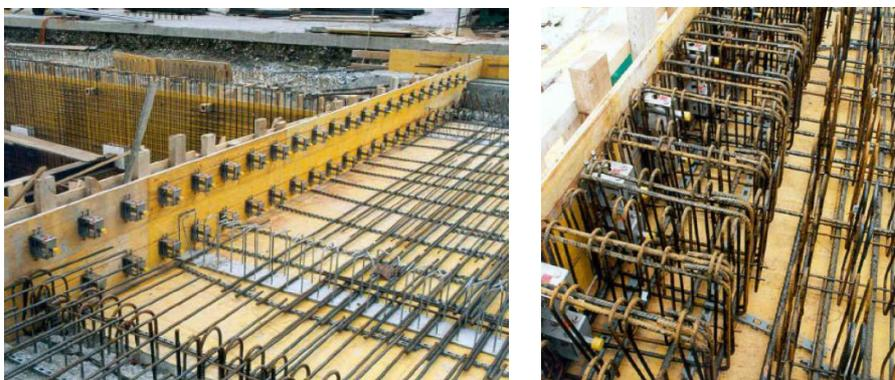
Abbildung 2.8: Aufwendige Anordnung von Querkraftdornen in Dehnfuge [24]
