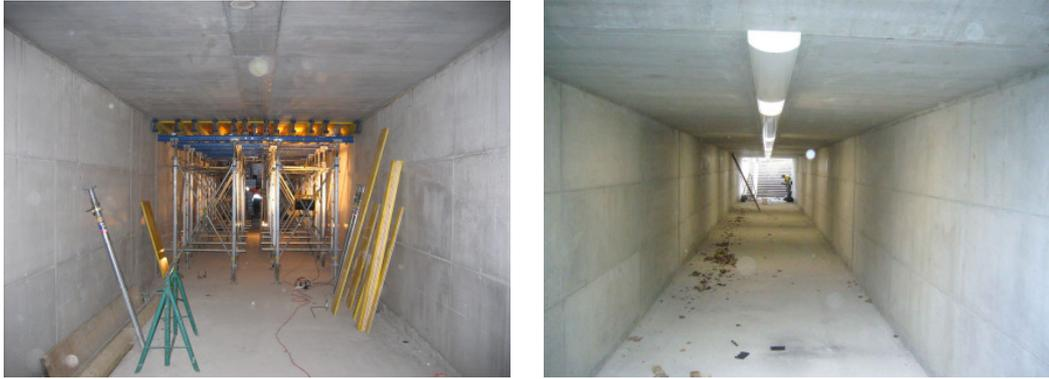
Abbildung 3.30: ÖBB-Personentunnel Einwanggasse: links Bauzustand,-rechts Endzustand
