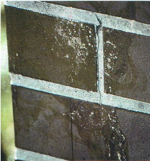
**Abb. 6.2-5: seitlich versetzter Riss durch Fuge und Eckverblender[7]**
