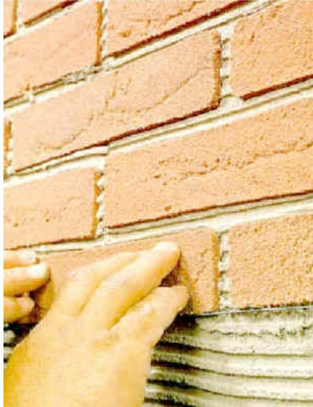
**Abb. 7.2-2: Von oben streifenweise, zwischen den Höhenmarkierungen, nach unten[90]**
