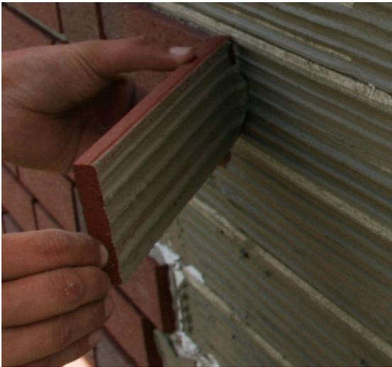
dadurch nicht zur dort auftretenden deutlichen Abminderung der erreichbaren Haftzugfestigkeit. Ebenfalls von hoher Wichtigkeit ist der Zeitraum der zwischen Auftragen des Mörtels auf die Wand und dem Ansetzen der Fliese darauf vergeht. Durch einsetzende Hautbildung auf den zu lange vorgezogen auf die Wand aufgetragenen Mörtel werden die Hafteigenschaften desselben erheblich verringert und Langzeitschäden sind vorprogrammiert.
