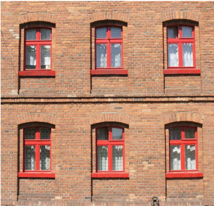
Als Sichtmauerwerk wird jenes Mauerwerk bezeichnet das unverputzt und unverkleidet und am fertigen Gebäude innen oder außen dauerhaft sichtbar ist. Es lässt sich in modernen Außenwandkonstruktionen nur durch einen zweischaligen Aufbau mit Kerndämmung, oder durch eine hinterlüftete Vorsatzschale realisieren, da ansonsten keine ausreichende Wärmedämmwirkung erzielt werden kann[93].
