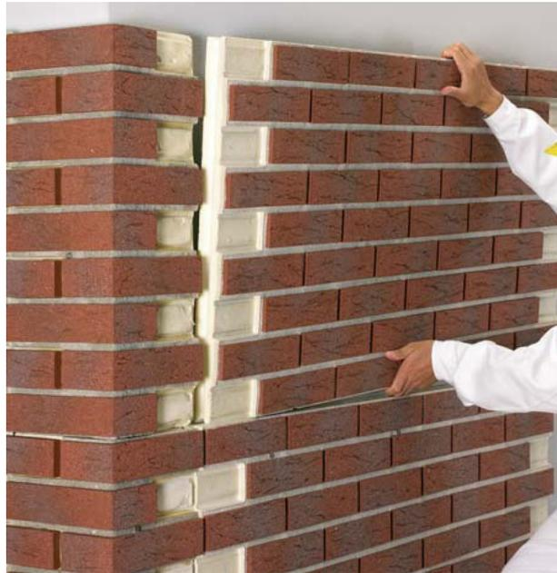
Abb. 7.5-1: System Isoklinker[81]
