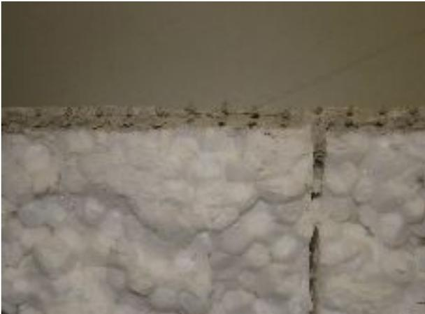
Aufgrund der durch die Materialeigenschaften bestimmten höheren Dichte der keramischen Bekleidungen, und der sich in der Folge daraus ergebenden höheren Beanspruchungen auf den Untergrund, die Wärmedämmung und die Armierungsschicht, muss diese allerdings stärker ausgeführt und doppelt bewehrt werden.
