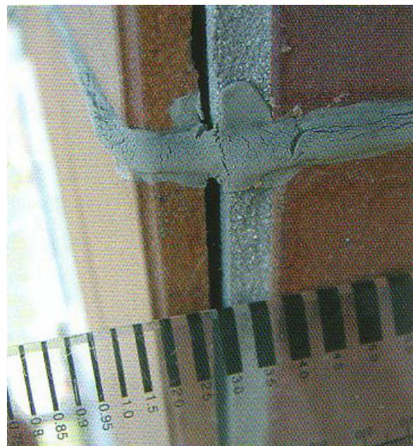
**Abb. 6.2-4: Klaffender Riss durch Verlust des Haftverbunds Keramik-Mörtel[14]**
