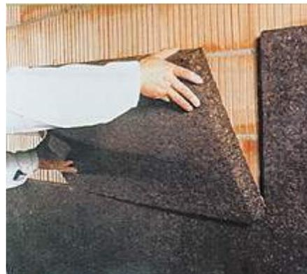
Abb. 4.3-7: Korkdämmung an Außenwand[68]
