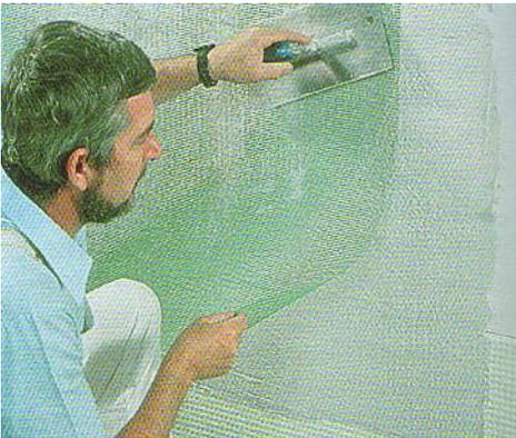
Fehler in der Praxis bestehen oft darin, dass das Armierungsgewebe in nur einem Arbeitsschritt mit dem Armierungsmörtel verbunden wird. Das führt dazu, dass das Bewehrungsgewebe nicht vollständig von Mörtel überdeckt ist, in der Folge daher die im Putz entstehenden Zugspannungen nicht sicher in die Bewehrung eingeleitet werden können und daraufhin an der Oberfläche sichtbare Risse entstehen.
