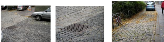
Die Versickerungsfähigkeit der Pflasterdecke kann wesentlich durch die geringe Fugenbreiten zwischen den Pflastersteinen, durch Verunreinigungen, durch die mit der Zeit immer stärker verdichteten Tragschichten und eine etwa höhere Längsneigung der Verkehrsfläche beeinträchtigt werden.
