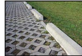
Durch Einsetzen von fugenoffenen Randsteinen, die die Parkfläche vom Grünbereich trennen, wird die Niederschlagszufuhr zu der Mulde problemlos gewährleistet.
