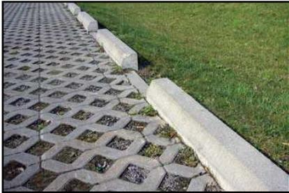
Durch Einsetzen von fugenoffenen Randsteinen, die die Parkfläche vom Grünbereich trennen, wird die Niederschlagszufuhr zu der Mulde problemlos gewährleistet.
