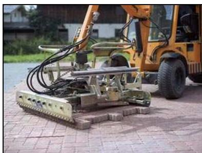
Abb.6.7.: Verlegung mit maschineller Hilfe (24)
