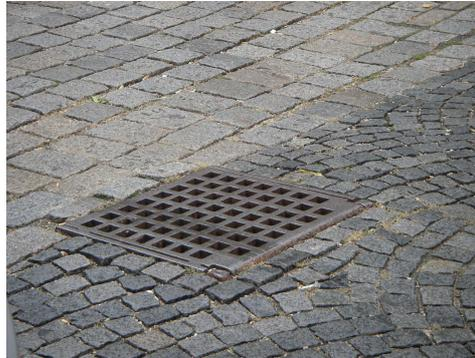
Die Versickerungsfähigkeit der Pflasterdecke kann wesentlich durch die geringe Fugenbreiten zwischen den Pflastersteinen, durch Verunreinigungen, durch die mit der Zeit immer stärker verdichteten Tragschichten und eine etwa höhere Längsneigung der Verkehrsfläche beeinträchtigt werden.
