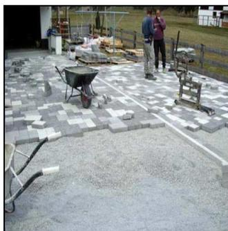
Abb.6.5.: manuelle Pflasterverlegung (46)
