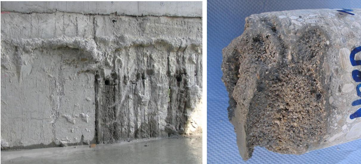
Abbildung 3-6: li: Schlitzwand intakt und geschädigt; re: Bohrkern aus der geschädigten SW
