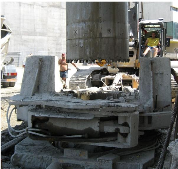
Abbildung 2-3: Bohrrohr mit Schneidschuh
