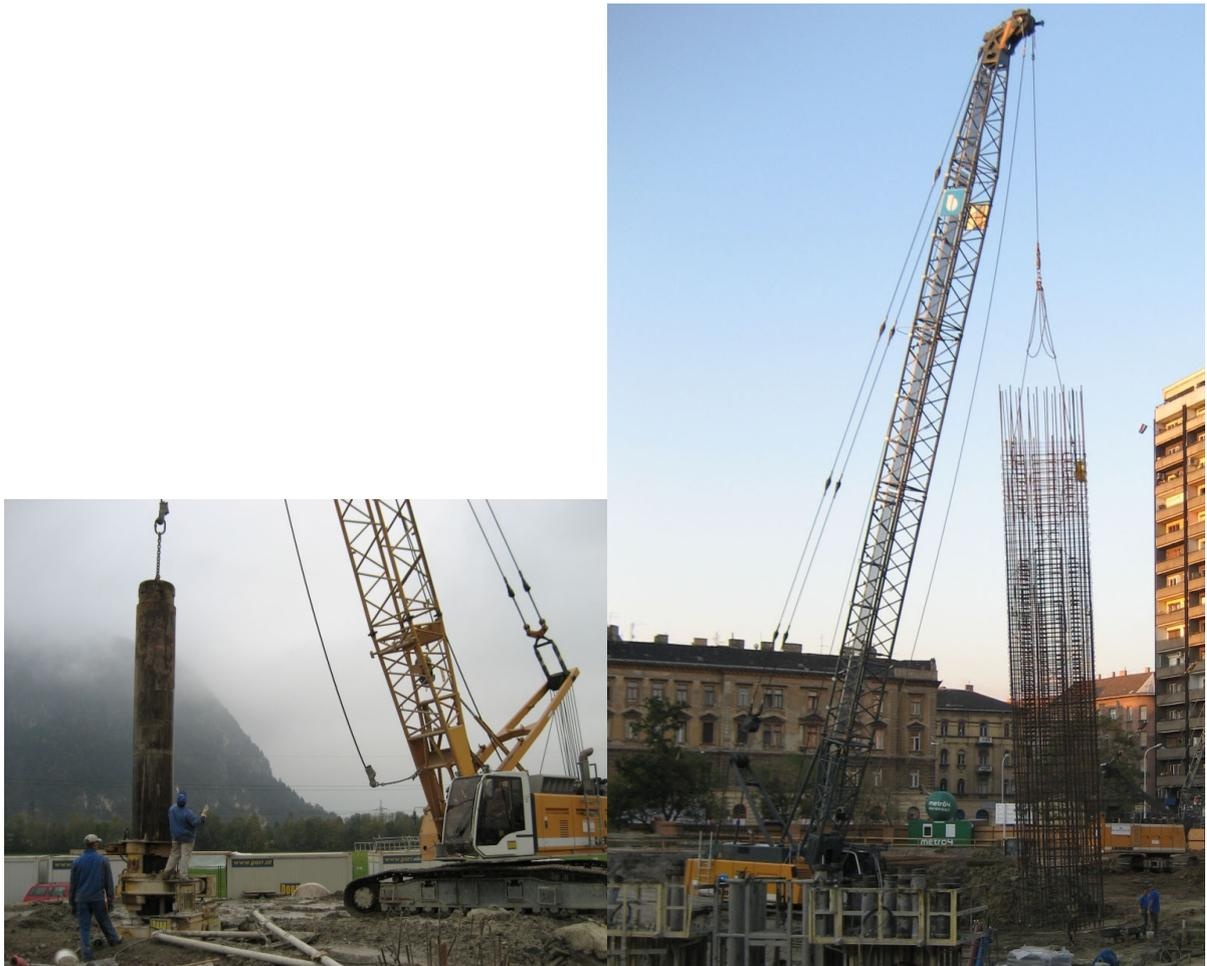
Abbildung 2-11: Einbau der Abschaltrohre und der Bewehrung
