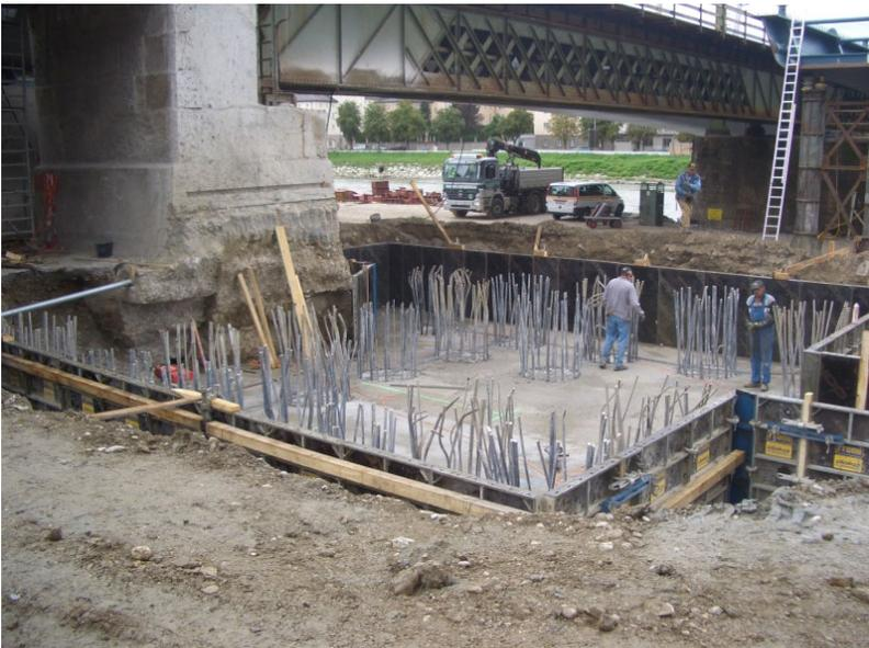
Abbildung 2-8: Fertig abgestemte Pfahlköpfe
