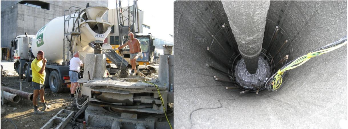
Abbildung 2-7: Betoniervorgang mit Blick ins Bohrrohr
