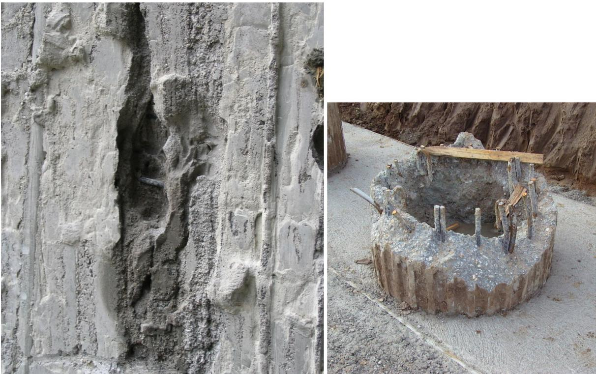
Abbildung 3-7: li: Durch Bluten verursachte Freilegungen der Bewehrung; re: Nachsackungen des Bohrpfahlbetons (Bohrpfahlkaries)
