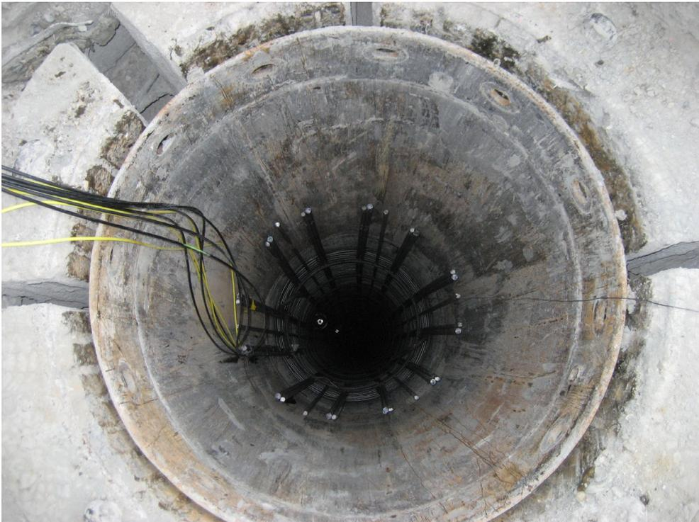
Abbildung 5-7: eingebauter Bewehrungskorb mit elektrischen Leitungen
