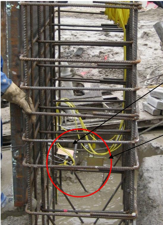
Messung des Betondrucks in vertikaler Richtung (zu Vergleichszwecken)
