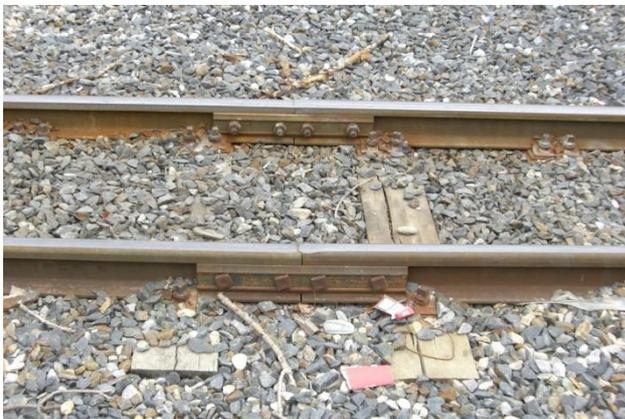
**Bild 7: Schienenstoß**
