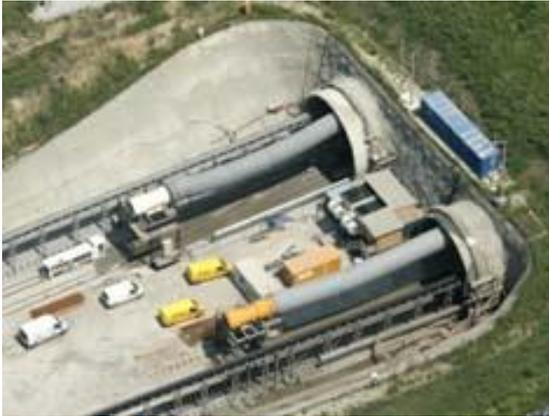
**Bild 17: Luttenleitungen am Tunnelportal<sup>147</sup>**
