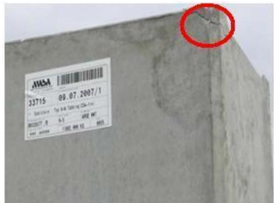
Schäden an den Tübbingungen können durch unsachgemäßen Transport, beim Ausschalen oder beim Einbau durch den Erektor auftreten, in den seltensten Fällen gefährden sie jedoch die Tragfähigkeit des Ringes. Abplatzungen (siehe Bild oben, rot gekennzeichnet) können einfach mit Reparaturmörtel ausgebessert werden.
