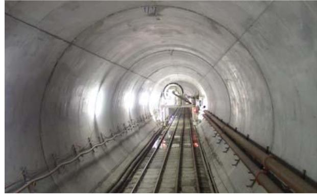
**Bild 15: Innenschalenausbau**
