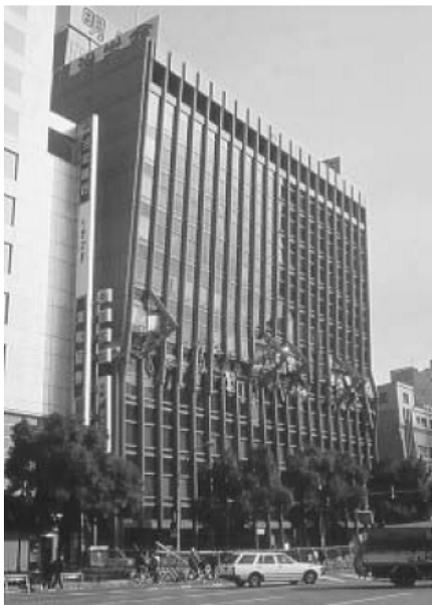
*Abbildung 4      Auswirkung eines zu weichen Obergeschoßes (Kobe, Japan, 1995) [7]*
