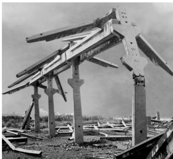
*Abbildung 9 Mangelnde Bemessung eines vorgefertigten Industriebaus (Adapazari Türkei 1999)[7]*
