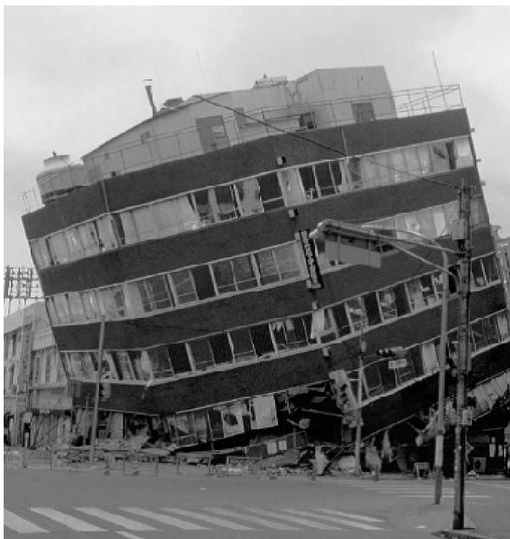
*Abbildung 5      Auswirkungen einer exzentrischer Aussteifung (Kobe, Japan, 1995) [7]*
