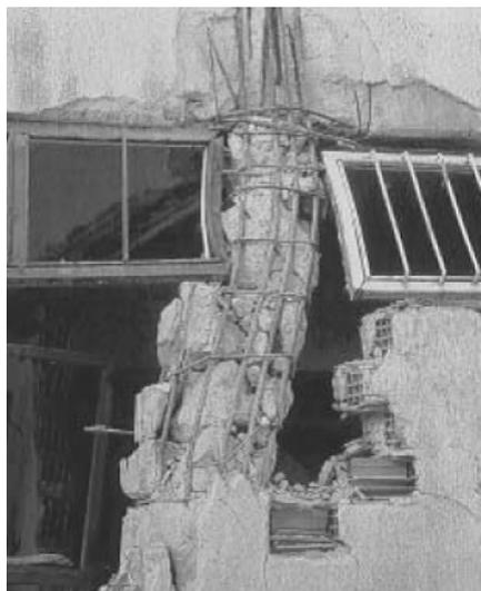
*Abbildung 8 Mangelnde Bewehrungsführung und Phänomen der „kurzen Stütze“
