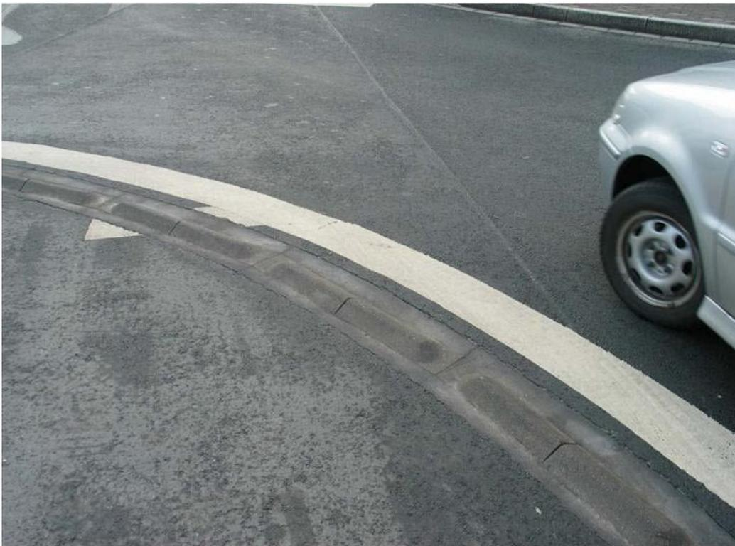
Abb.41 – Umbau zu Mini-Kreisverkehr: die Kreisinsel ist die frühere Fahrbahnoberfläche, Randeinfassung durch Beton-Leitelemente. [7]
