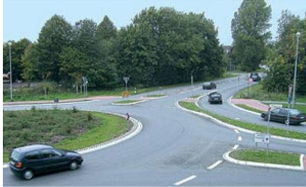
Abb. 32: Durch diesen Bypass sind die rechtsabbiegenden Fahrzeuge unabhängig von diesen, die sich im Kreis befinden. Das hilft der Leistungsfähigkeit und der Sicherheit. [10]
