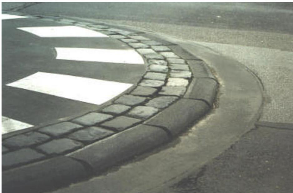
Abb. 39 – Bord zur Einfassung der Kreisinsel. Hier ist er sehr attraktiv ausgefertigt – mit Naturpflaster und Asphalt. [7]
