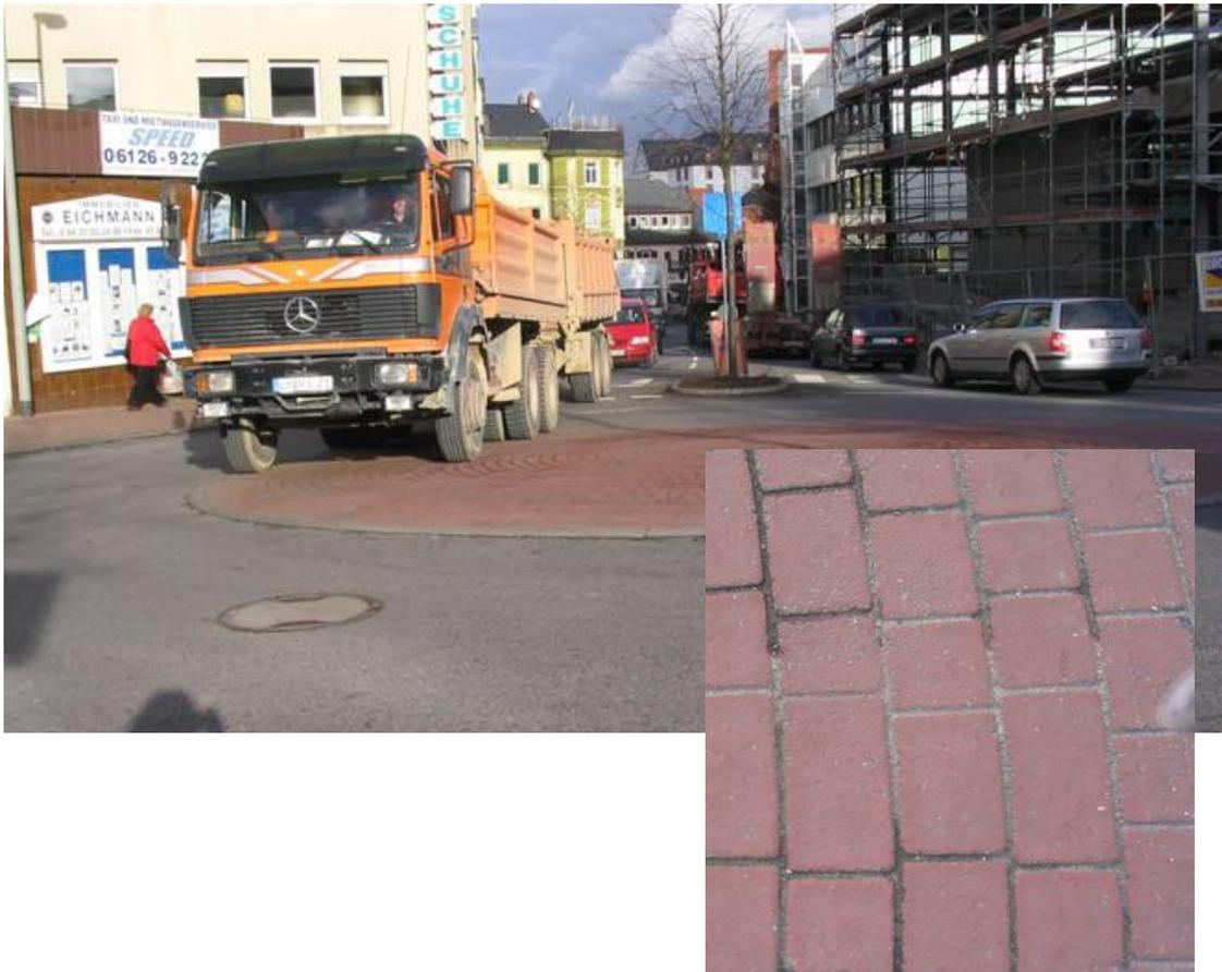
Abb. 38: Kreisinsel aus Betonpflaster. Hier wird auch die Schleppkurve eines LKWS mit Anhänger gezeigt. [28]
