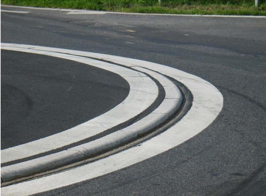
Abb. 40: Kreisinsel aus Asphalt. Randeinfassung durch Rundborde. [7]
